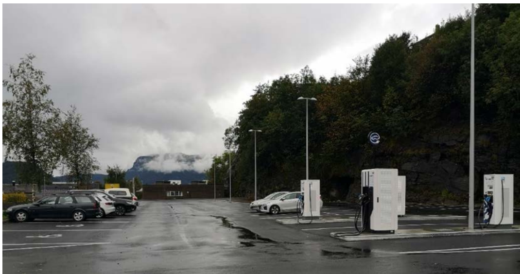
Figur 8: Parkeringsareal med i overkant av 70 plasser og fire ladestasjoner for el-bil ved fylkesveien (Kyrkjegata). Foto: Marianne Knapskog.
