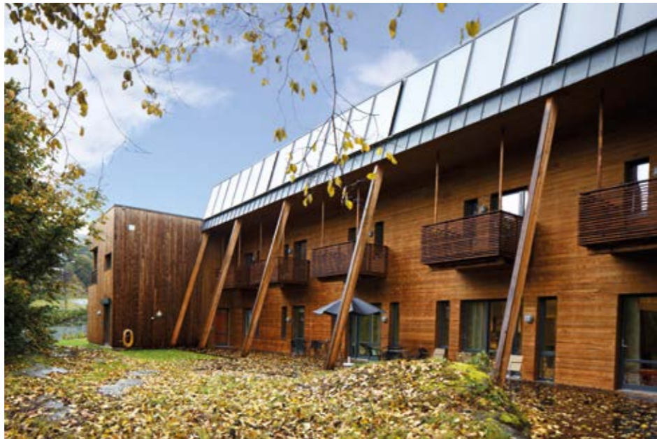
Sørvendt fasade med solfangere. Foto: Vegard Giskehaug
