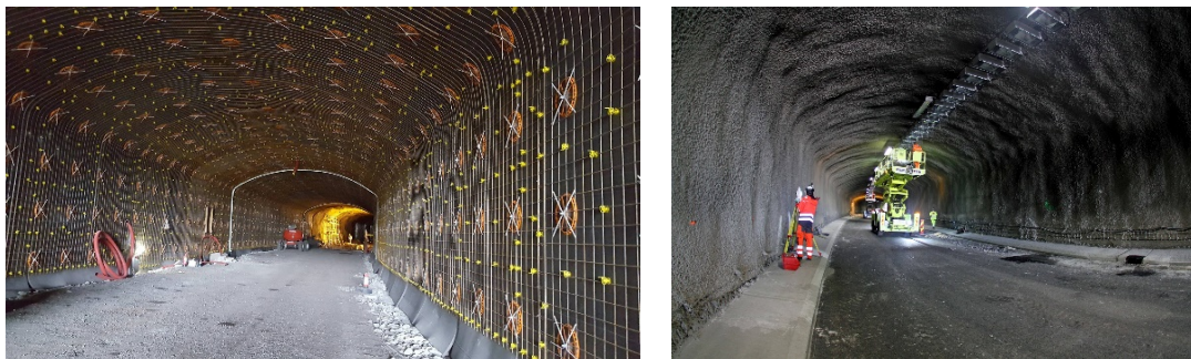
Figur 1: Rehabiliteringsarbeid i Brynstunnelen. Kilde: Statens vegvesen.
