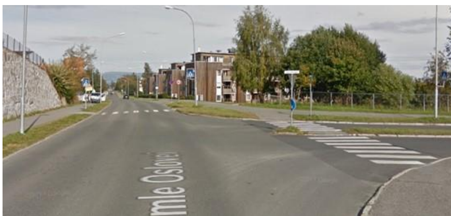
Figur 12: Sted 2, Gamle Oslovei (nordover retning). (Kilde:Google maps)
