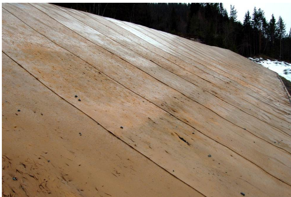
Figur 28. Treffpunkt i gummiduk som dekkjer kulefanget på ei korthaldsbane. Variert bruk av målmateriell og ulike skyteposisjonar gjev stor spreieing av treffpunkt i kulefanget. Foto MB.
