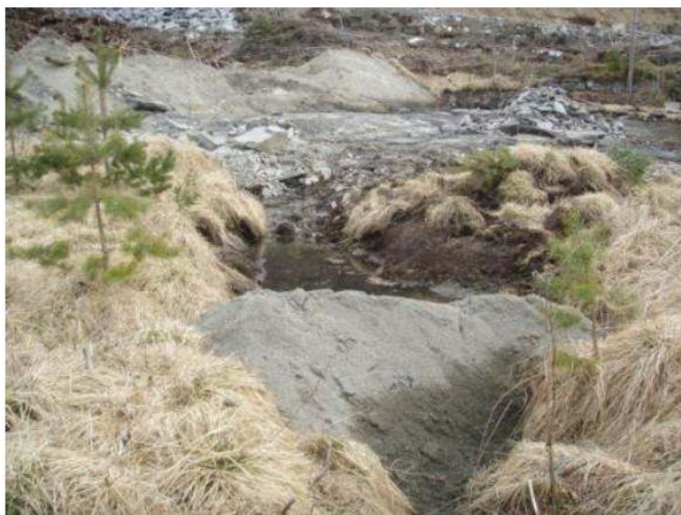
Figur 35. I tillegg til kulefanget bak skiskyttarblinkane vart arealet under blinkane og 6-8 meter tilbake mot skyttar sanert. Bekken er lukka med sandfilter slik at forureining ikkje skal spreia i tiltaksfasen. Foto Cowi.
