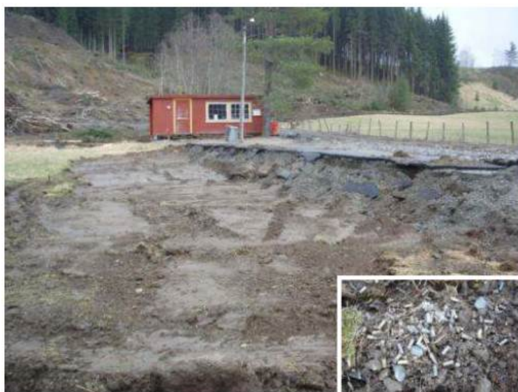
Figur 36. Eit større område ved standplass på skiskyttarbana vart sanert p.g.a. forureining frå tomhylser. Foto Cowi.
