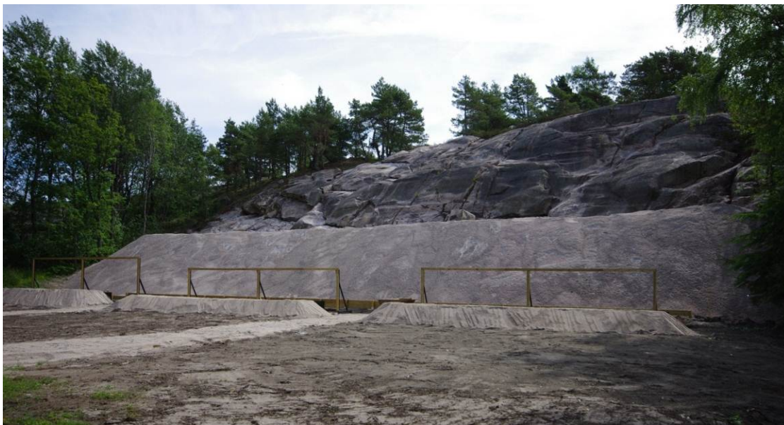
Figur 29. Pistolbaner ved Regimentsmyra, Fredrikstad. Heile kulefanget vart grave ut men ein del av massane kunne gjenbrukas fordi dei var moderat forureina og fordi det ville verte tilført ny forureining. Også området bak kulefanget var sterkt forureina på grunn av rikosjettar og dette arealet vart sanert ved graving og slamsuging. Foto MB.
