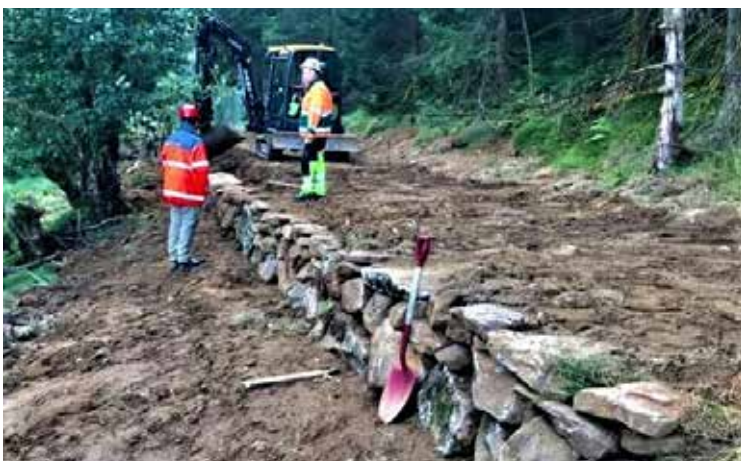
Rekonstruert mur ved Drægebø, Sunnfjord kommune. Her er alle steinane av ulike storleik og fasong og utan rette kantar, noko som gjev ei ganske grov utforming, slik resten av muren langs vatnet har. Foto: Tine Eikehaug, Statens vegvesen.
