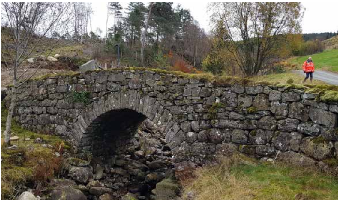
Postvegbru i Skånevik, Etne, som Statens vegvesen har vore med og sikra gjennom vedlikehald. Foto: Bjørn Eikje Ramberg, Statens vegvesen.
