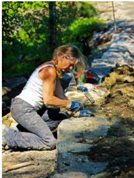
Tørrmurar Berit Bruvik restaurerer mur i postvegen ved Våge i Lindås 2017. Foto: Tine Eikehaug, Statens vegvesen.
