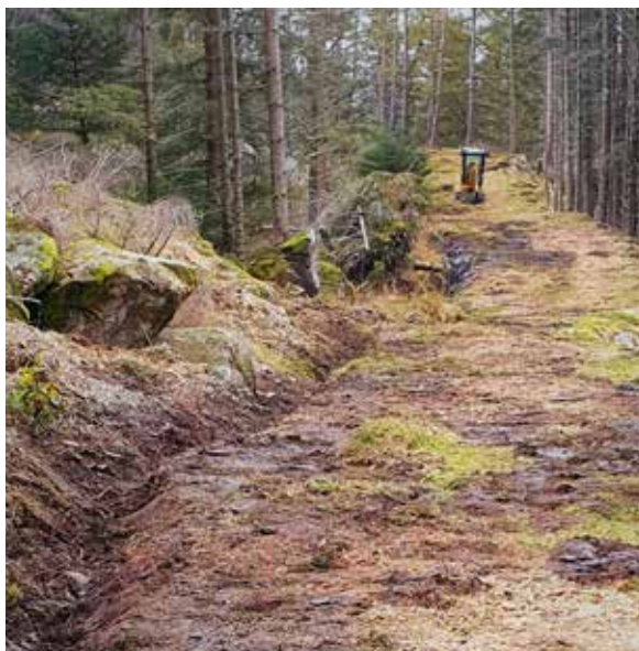
Grøftegraving med lita beltegående maskin. Denne vegstrekninga var svært attgrodd og skadd, og etter at skog og kratt vart fjerna, blei grøftene forsiktig grave fram att, heile tida med fokus på å ikkje vere borti vegmurane under torva. Massane frå grøfta er delvis lagde i vegen, og vil etter kort tid bli eit fint grønt dekke. Foto: Jarle Halsvik.
