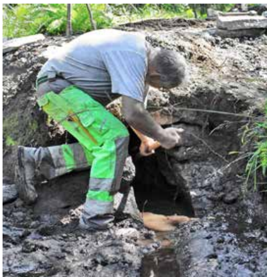
Reinsking av utlaupet på ei stikkrenne kan ein gjere med ein spade. Foto: Tine Eikehaug, Statens vegvesen.
