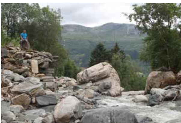
Svidal bru før og etter: Eit stort jordskred i Jølster 30.07.2019 tok med seg både delar av postvegen samt heile brua (bildet over). Foto: Stig Roar Eide.
