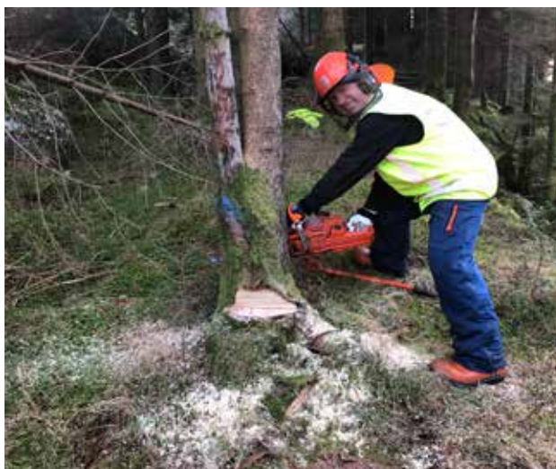
Manuell hogst må til, som her i Nordgulen. Dei store trea vart henta ut med maskin som tok seg sidevegs inn i terrenget, for å unngå å køyre på postvegen. Foto: Marit Anita Skrede, Statens vegvesen.
