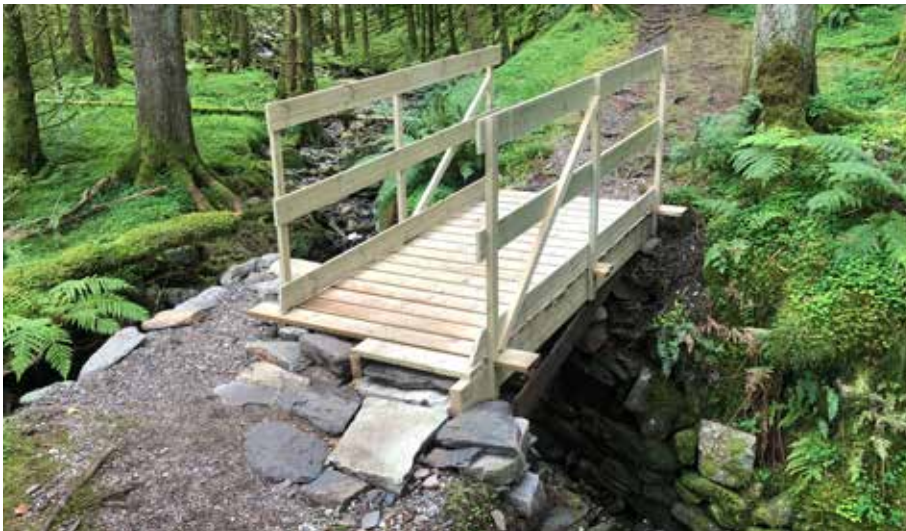
Ei enkel lettbru i tre som blir lagt rett på dei tørrmura landkara utan å endre på muren kan vere eit greitt alternativ for å sikre framkome for turgåarar. Foto: Bjørn Christian Grassdal, Statens vegvesen.
