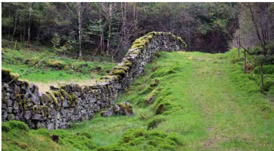
Objekt 164 i Lindås ligg i eit småkupert landskap gjennom både innmark og utmark. Foto: Jan Adriansen, Statens vegvesen.
