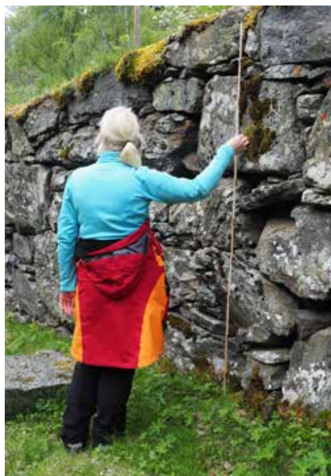
Høge vegmurar i sidebratt terreng. Foto: Izabela A. Chlewicka, Statens vegvesen.
