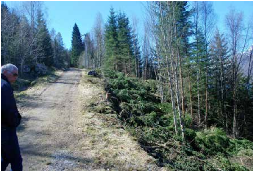
Hogstavfall må ikkje leggjast inntil vegen som her, men helst samlast i haugar eit stykke unna. Foto: Marit Anita Skrede, Statens vegvesen.
