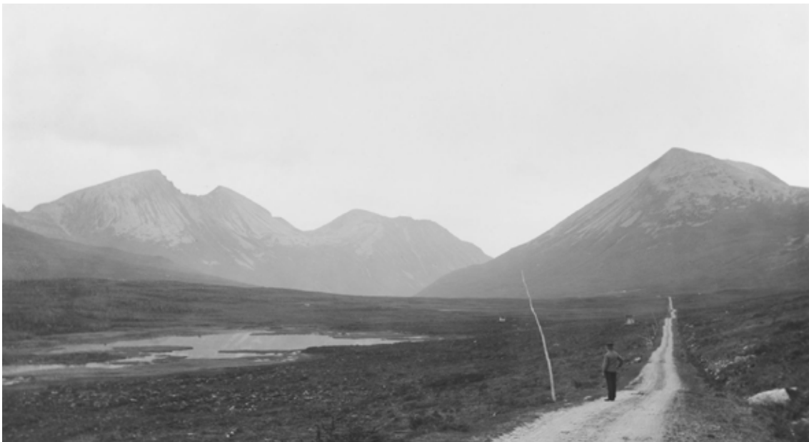
Lange, rette linjer – det franske prinsipp – var idealet i vegbygginga på slutten av 1700-talet. Her eit område der det var mogleg – på strekninga over Ørskogfjellet. Foto frå ikring 1880 av Knud Knudsen, eigar Spesialsamlinga, UiB.
