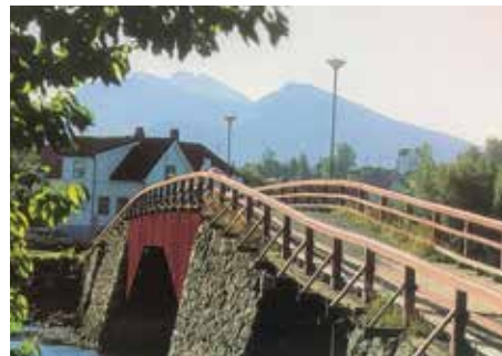
Objekt 20 er eit vegmiljø med tre bruer som ligg parallelt over Straumen ved Vestnes og viser utviklinga i samferdsla dei siste 180-åra. Gamle Straumsbrua er den eldste, og bygd som del av postvegen. Postvegen er også verna på begge sider av brua. Foto: Tine Eikehaug, Statens vegvesen.
