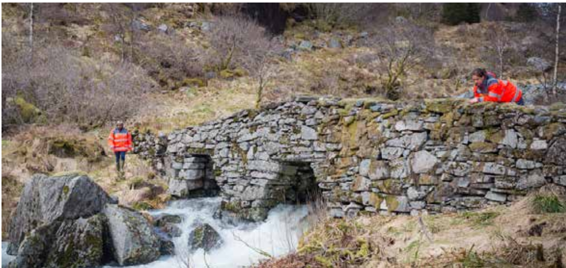
Trangane bru i Nordgulen var ei av dei første bruene oppførte av berre stein, i 1788. Eine brukaret vart restaurert i 2019. Foto: Silje Drevdal, Statens vegvesen.
