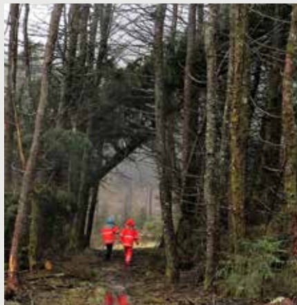
Postvegen i eit skogsfelt, der uttak kan gjere stor skade på vegen om han vert brukt som anleggsveg. Foto: Marit Anita Skrede, Statens vegvesen.
