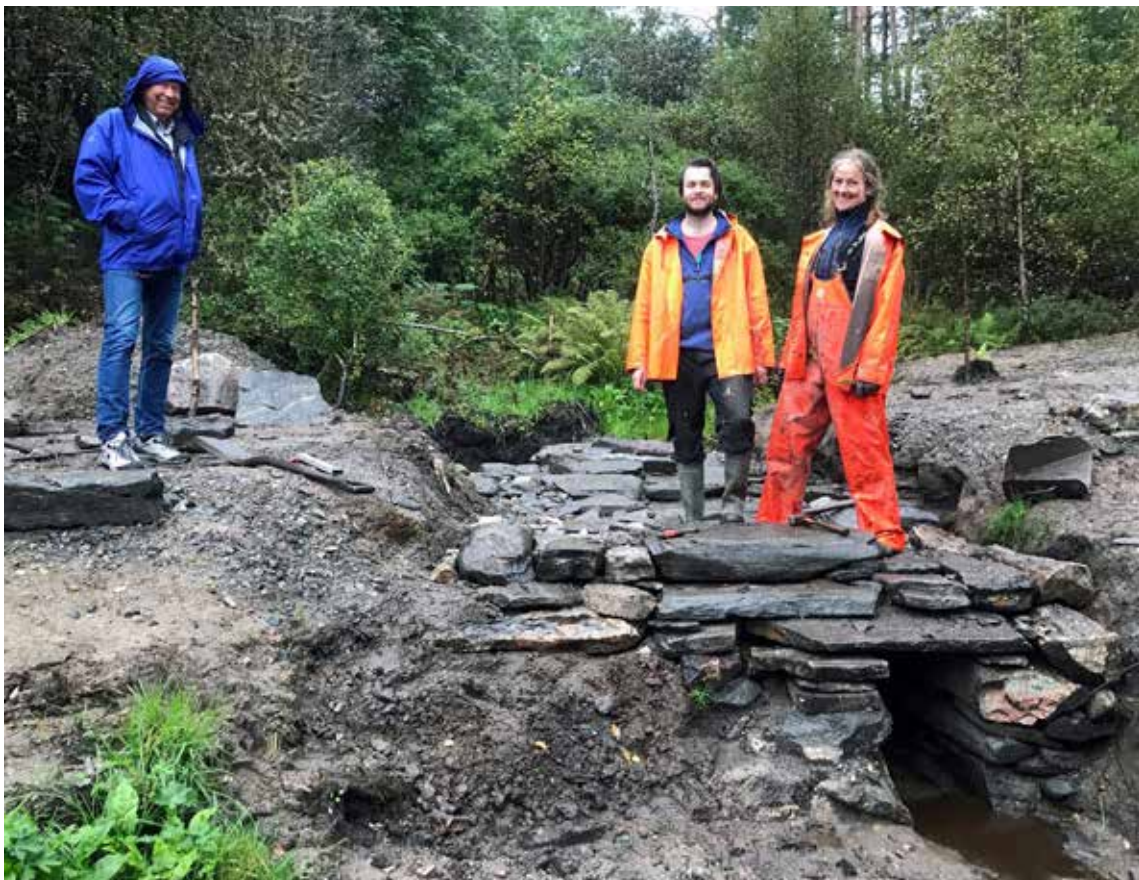
Ei litt større stikkrenne restaurert etter prinsippet om å bruke opp att steinane som opphavleg låg i stikkrenna. Knekte heller vart bytta ut, og dei kollapsa kantane vart lødd opp og lagt på plass. Til dette arbeidet vart det brukt fagfolk med tørrmuringskompetanse. Foto: Tine Eikehaug, Statens vegvesen.
