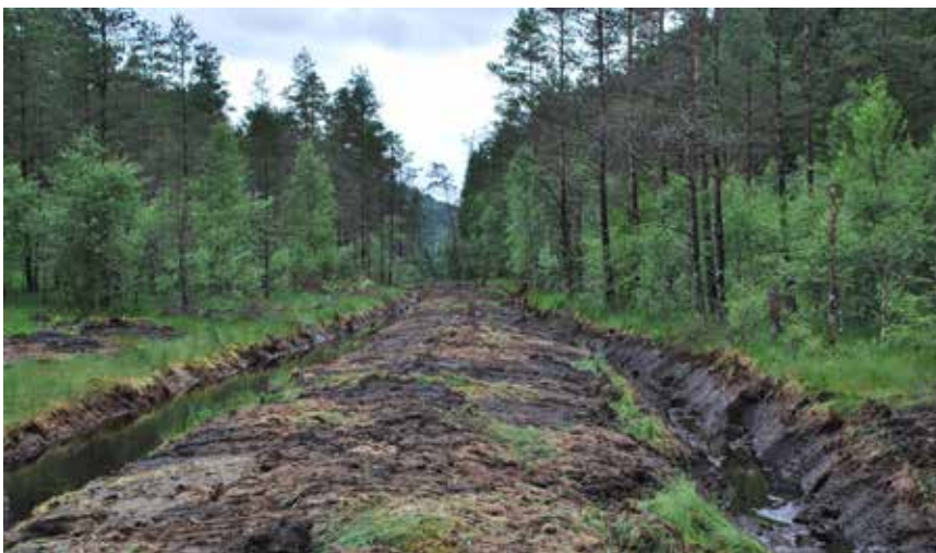
Frå postvegen gjennom myra ved Tunvald i Sunnfjord kommune, der grøftene vart greve opp att. Alt året etter var vegen tørr og fast. Noko av massane frå grøfta vart også lagt inn på vegen for å byggje han meir opp i terrenget; nett slik det vart gjort då vegen vart bygd. Foto Marit Anita Skrede, Statens vegvesen.
