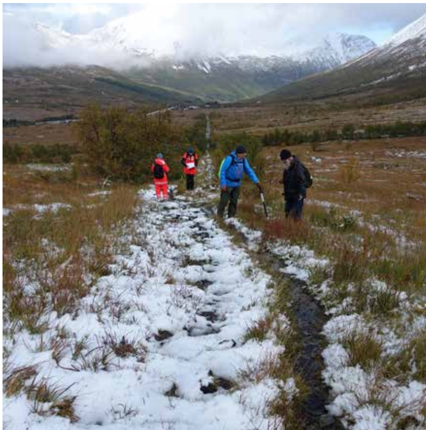
Tette grøfter og vatn som renn feil. Foto: Izabela A. Chlewicka, Statens vegvesen.
