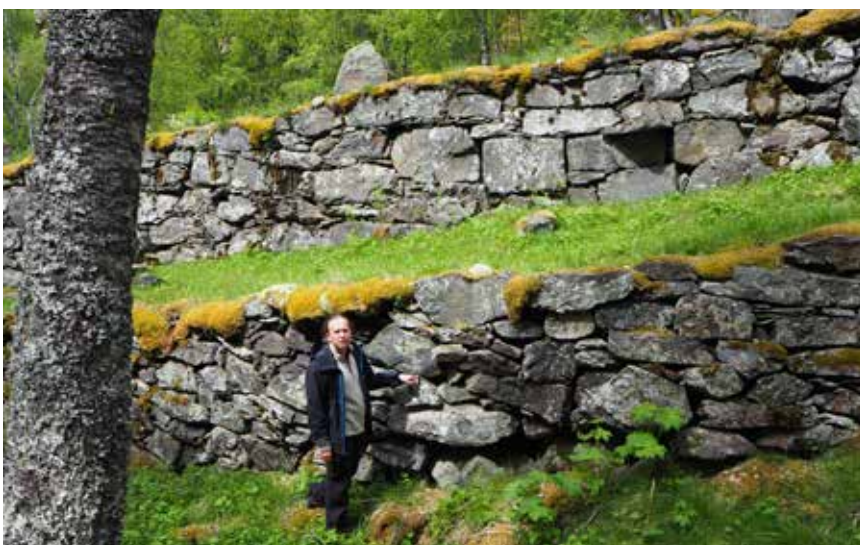
Det er forskjell på vegmurar. Vegmuren frå 1840-talet (øvt) har meir rette skift og avlange heller, medan vegmuren frå kring 1800 har ujamne skift og lite tilhogd stein. Små nyansar, men likevel synlege. Foto: Izabela A. Chlewicka, Statens vegvesen.
