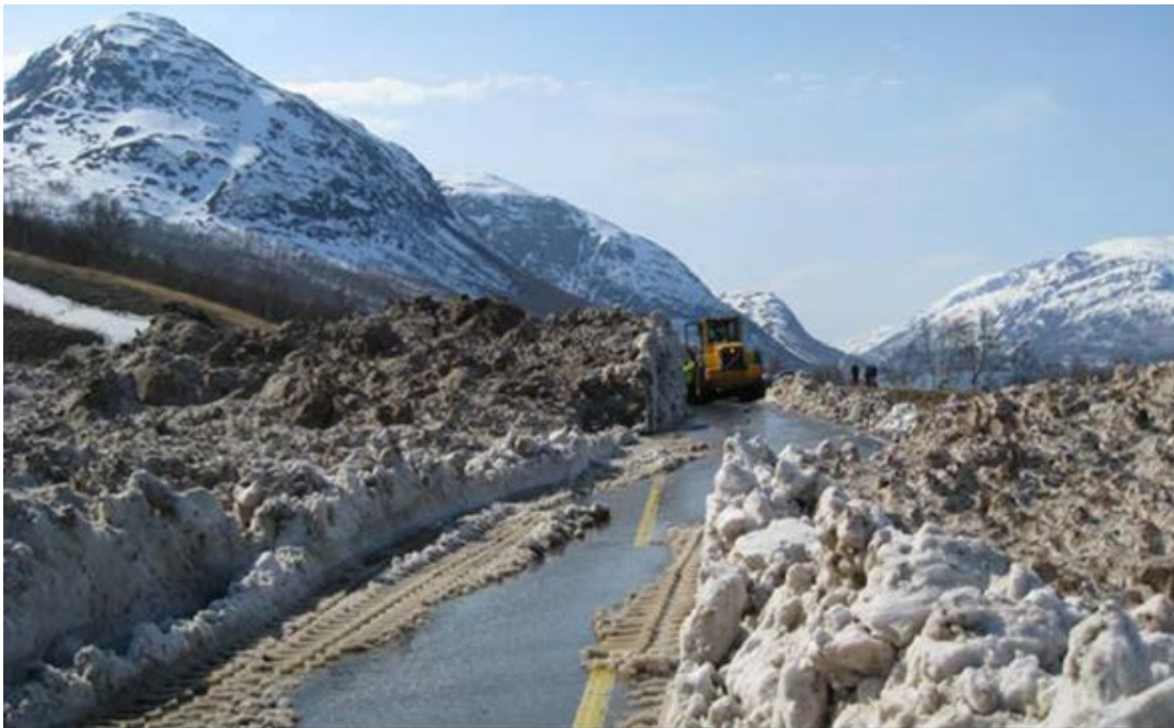
Figur 46. Sørpeskred på veg på E6 ved Herranes i Alta kommune 15. mai 2011. En kraftig temperaturstigning førte til flere sørpeskred. Ved Herranes er sørpeskred en kjent problemstilling, og vegen er sikret med fangmagasin og bygget på kraftig fylling. Flere sørpeskred utløses vanligvis, og denne gangen så store snømengder at magasinet ble fylt. God drenering i fylling hindret skader på veg.
