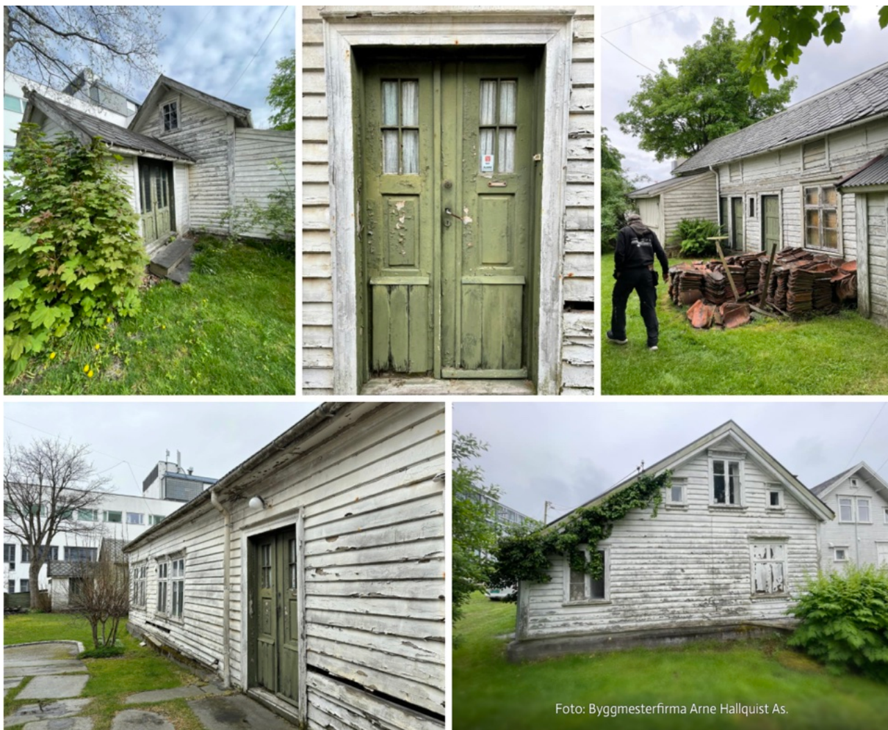
Foto: Hus i Haugesund var rivningstruet, ble flyttet til Vibrandsøy, der det søkte etter og fikk nye eiere. Fotograf Byggmesterfirma Arbe Hallquist AS.
