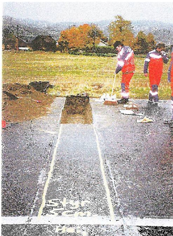
Bilde 1 Oppgraving av prøvehull
