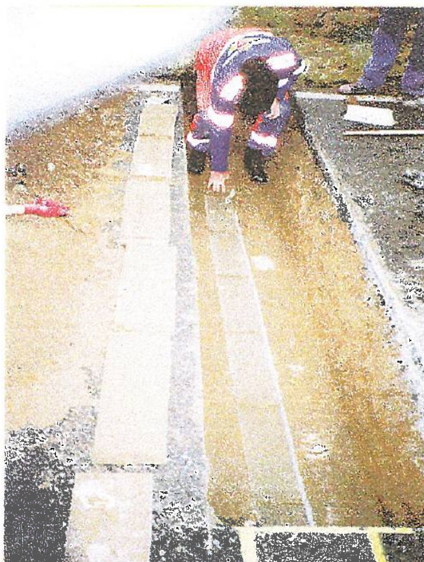
Bilde 3 Utskjæring av isolasjons prøver
