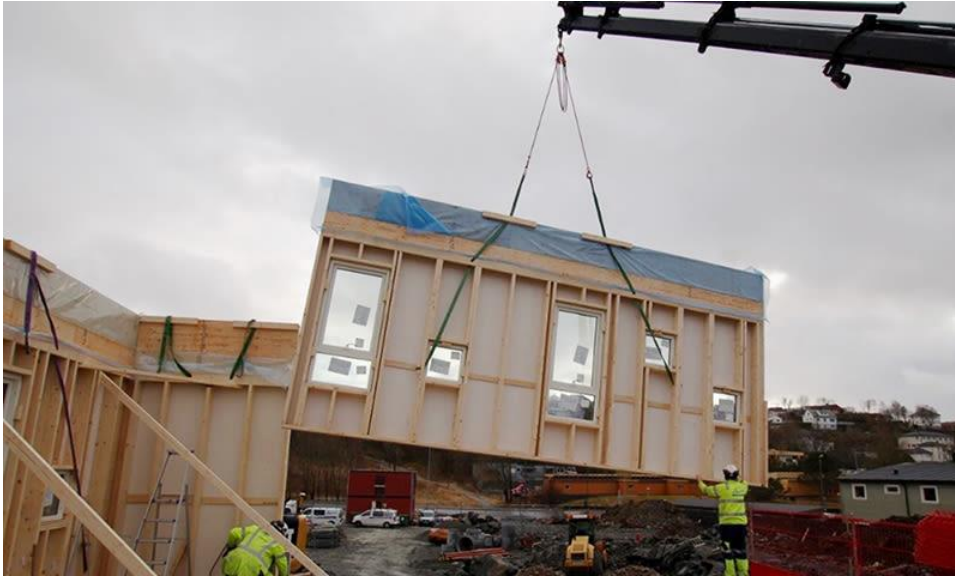
Bilde 7. Elementbygg som løftes på plass. Foto: Byggmakker
