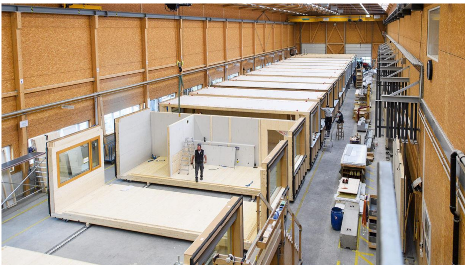
Bilde 8. Bygging av moduler på fabrikk. Foto: Funksjonell.no
