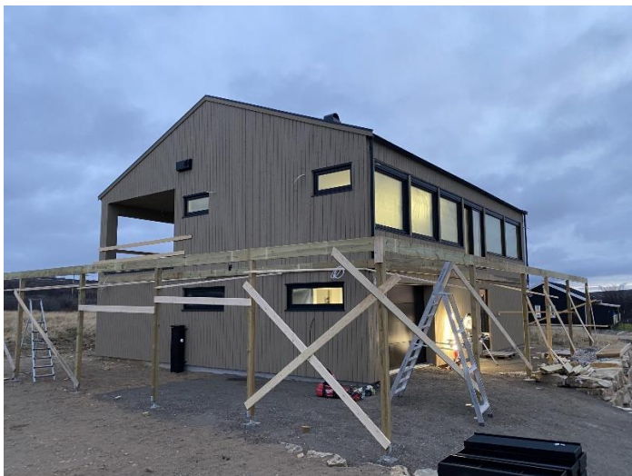
Bilde 1. Enebolig under oppføring av Arktisk Bygg AS, Vadsø. Foto: Arktisk Bygg AS.
