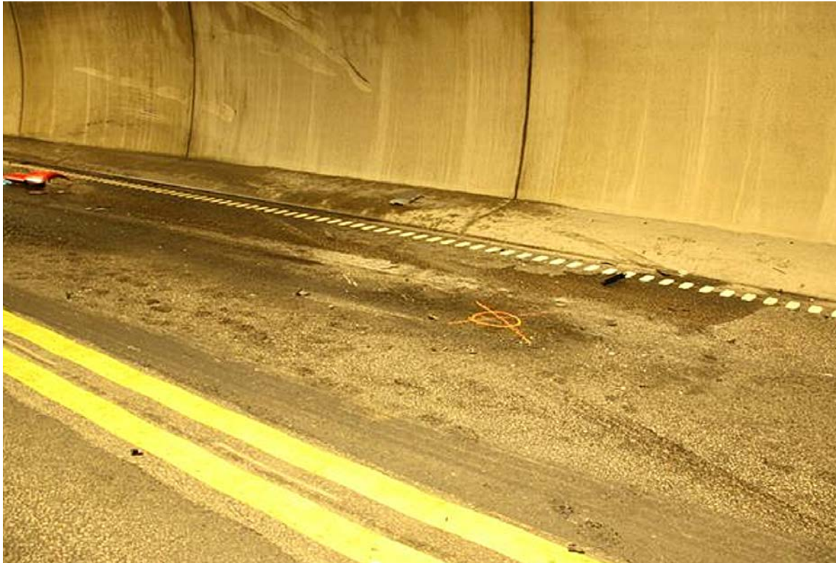
Bilde 2.3.2.1: Spor etter en dødsulykke i tunnel.
