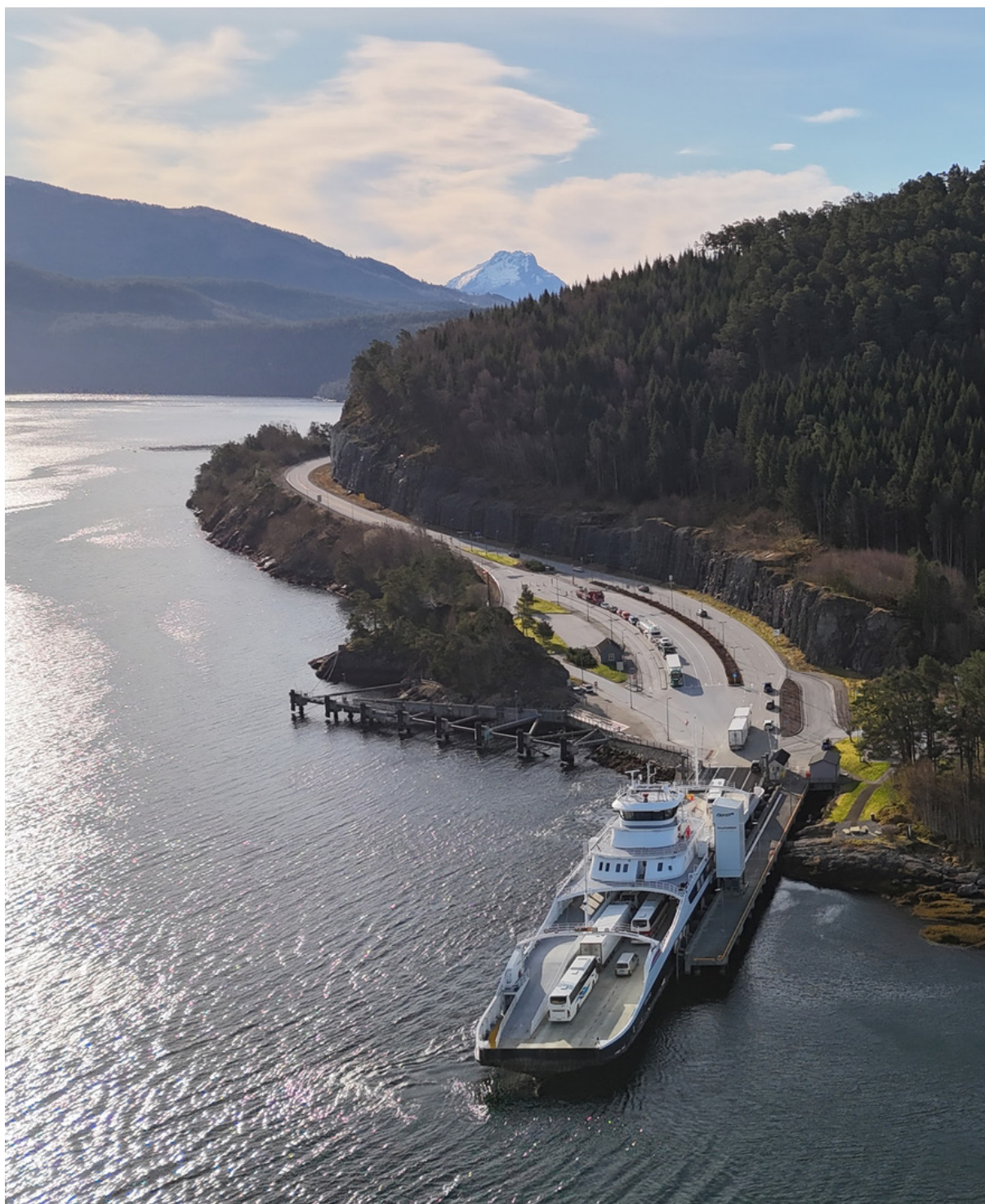
MF Eidsfjord ved kai på Anda ferjekai på riksveiferjesambandet Anda – Lote. Foto: Harald Berstad, Statens vegvesen.
