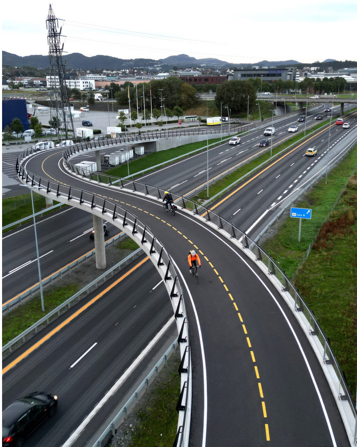
Bildetekst: Sykkeltamvegen mellom Stavanger – Sandnes. Arbeidet med å bygge den siste etappen har startet. Hele strekningen mellom Stavanger og Sandnes vil åpne sommeren 2025. Foto: Øyvind Ellingsen, Statens vegvesen.
