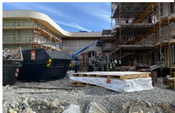
Torvbråten skole - bygningen kommer på plass. Foto: Asker kommune.
