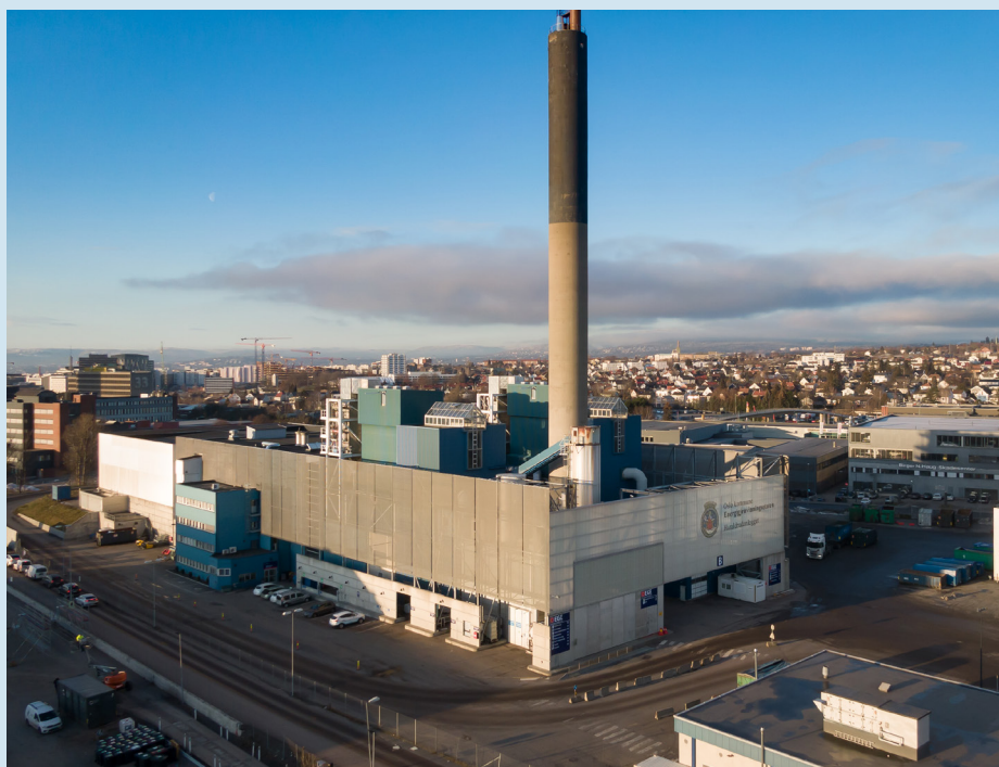
Photo: Haraldrud waste sorting facility in Norway © Oslo Kommune Renovasjons- og gjenvinningsetaten
