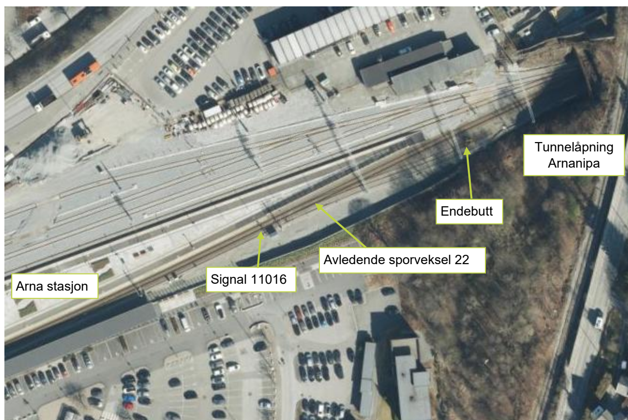
Figur 13: Arna stasjon. Foto: Norge i bilder. Påtegninger: SHK
