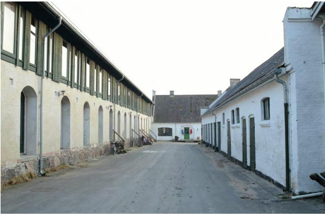
Svanholm Svanholms egne arkitektbeboere har tegnet ombyggingen av blant annet en tidligere stall til familieeboliger i rekke. Godset fra 1700-tallet med driftsbygninger, åkre og husklynger, er omgjort til et bofellesskap hvor halvparten av beboerne jobber innenfor økologisk jordbruk. Foto: Svanholm gods
