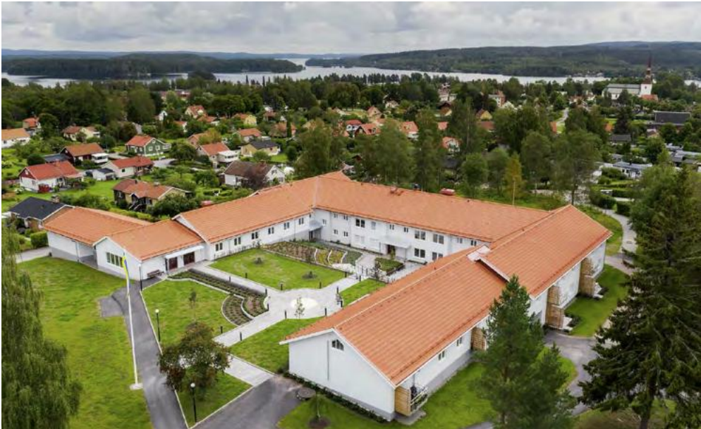
Smedjebacken Det tidligere sykehjemmet i Smedjebacken ble bygget om fra beboerrom til gode seniorboliger av Statens Bostadsomvandling. Foto: SBO
