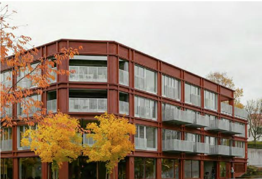
Sentrumsgården Transformasjon av Sentrumsgården i Heggedal er tegnet av Vignæs + Kosberg ++ arkitekter. Bygget fra 80-tallet var kontor og næring, og har nå blitt 25 leiligheter. Fasaden har blitt erstattet med større vinduer og trekledning. Foto: Magnus Åmand Lindquist
