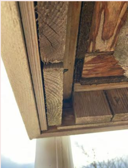
Bilde av Heradshus hjørne med oppbygning av vegg. Foto: Sol-Is arkitekter
