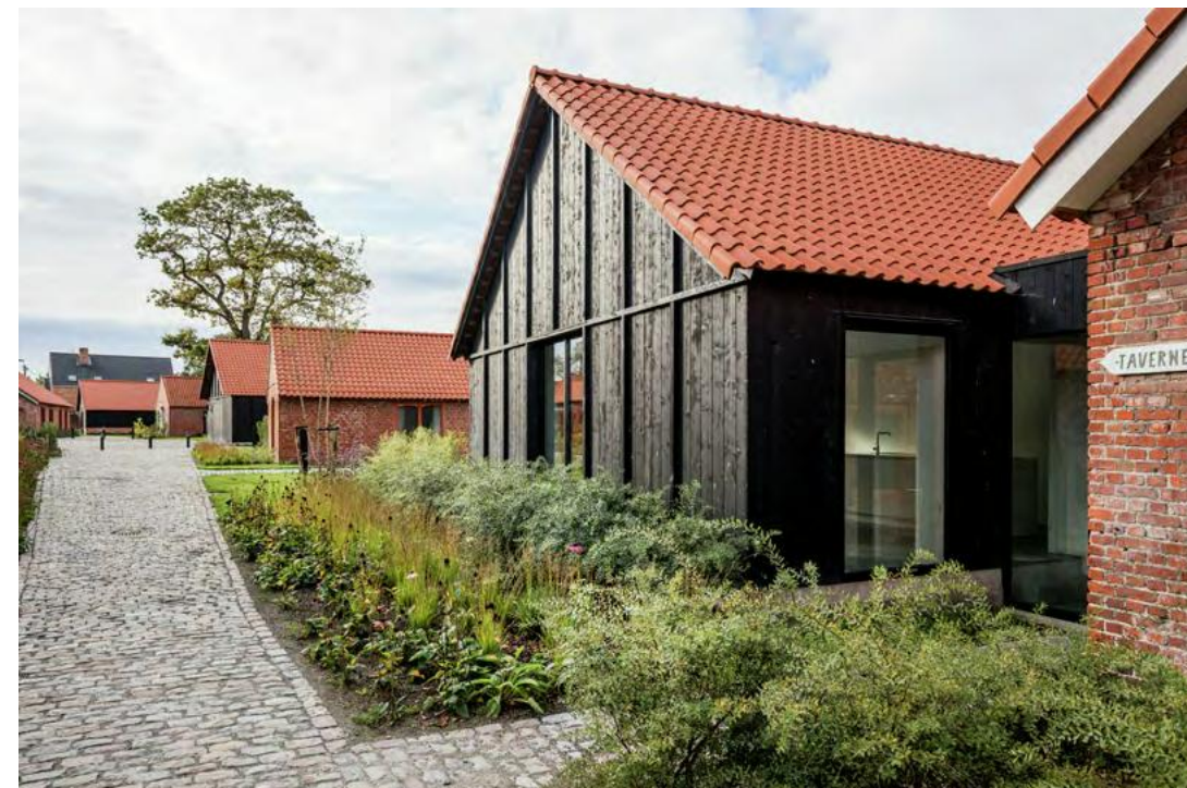
Qville B-architecten tegnet prosjektet Qville med 45 rimelige boliger i vernede stallbygninger i Belgia, med felles fasiliteter og økologiske byggematerialer. Foto: Jochen Verghote
