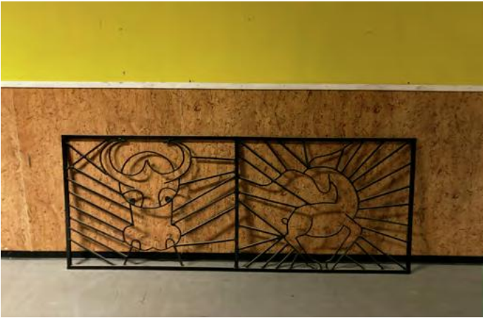
Det er mange lekne detaljer som minner om at bygningen ble brukt som skole. Identitetsskapende elementer ønskes å beholdes og få nytt bruk
