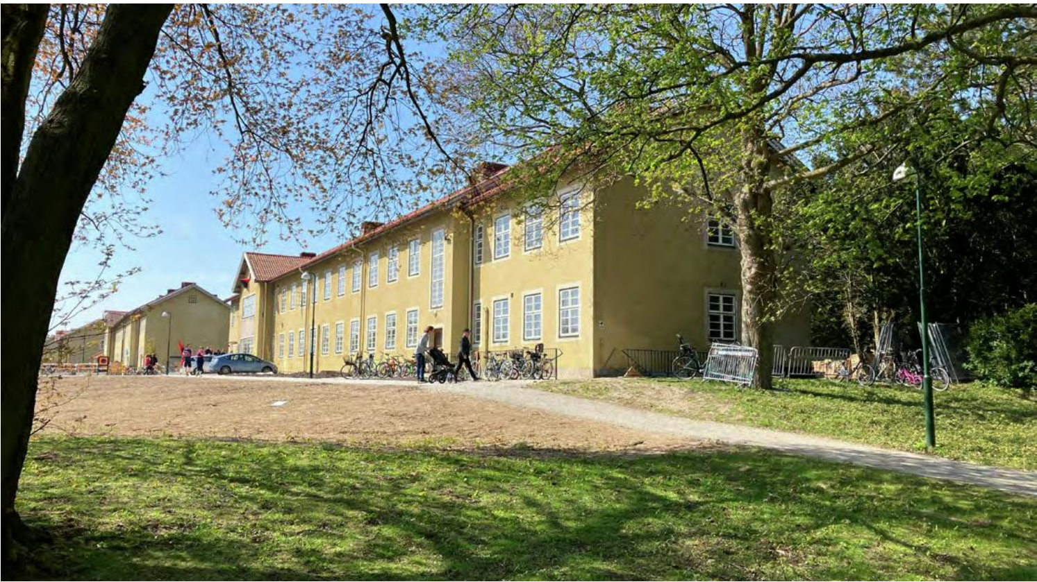
Røda Oasen I Malmö har gamle asyl blitt transformert til boliger. I ett av dem er det bofellesskapet Røda Oasen, som har brukt mye egeninnsats for å renovere både sin egen bolig og fellesrom. En entreprenør ble hyret inn for å ta de tyngste og vanskeligste oppgavene. Foto: Kerstin Kärnekull
