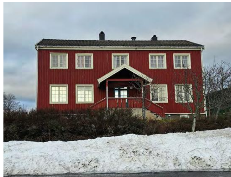
Heradshuset ligger tett på det nye kommunehuset. Kommunen har planer om å sette i gang med en sentrumsplan for å redefinere området.
