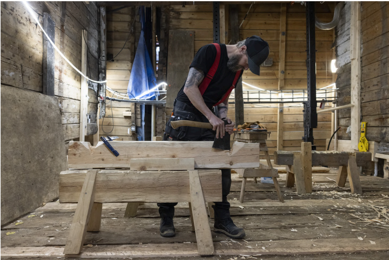
Bryggen i Bergen. Gjennom videreutdanning og utfordrende restaureringsprosjekter har håndverkerne ved Stiftelsen Bryggen utviklet betydelig ekspertise innen tradisjonelle håndverk. Foto: Trond A. Isaksen, Riksantikvaren
