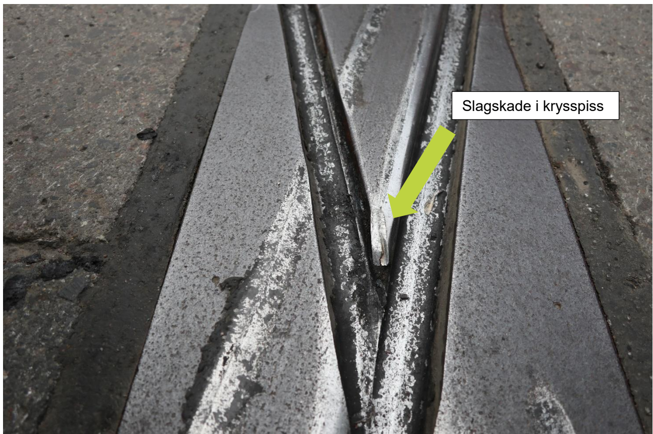
Figur 16: Skadet krysspiss tilhørende sporveksel 17. Foto og påtegning: SHK
