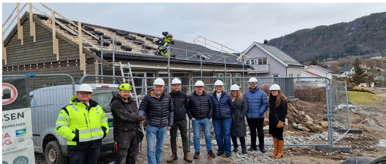
Formannskapet i Heim på befaring, sammen med utbygger
