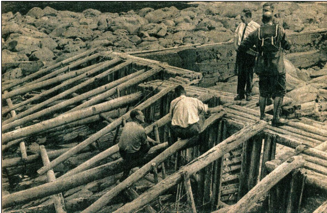
Fig. 2. Langteinlaget i 1964. Teinlagene var kraftige byggverk, oppført av tømmer og plank. Fisken kom opp fra høyre, slyngen i bakgrunnen. Skjønnsretten på befaring, mens en av eierne, Johan Rustad, sitter nederst til venstre med en fisk i teinen bak seg: Foto J. Antonsen.
