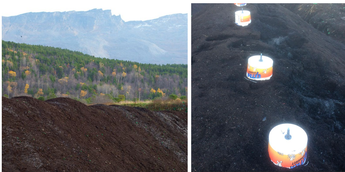
Figur 35 Reduksjon av klimagass emisjon med bruk av kompost /biohud lagt over kompostranker rankene.
