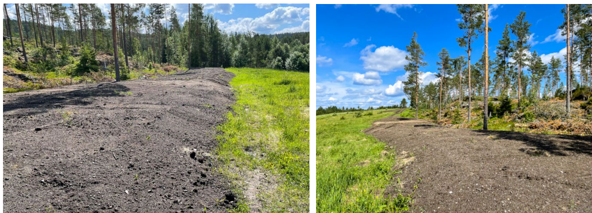
Figur 34 Utsatt kantsone mot skog er dekket helt til med kompost som metanoksyderende filtermateriale.
