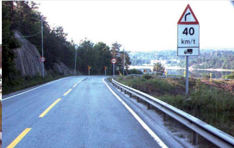
Vegens videre forløp etter vegetasjonsrydding
