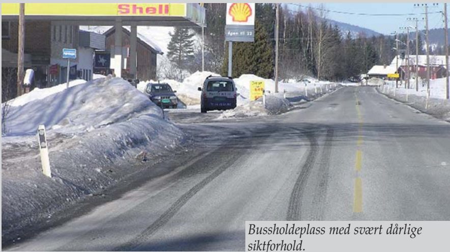
Bilveg og gang-/ sykkelveg er brøytet, men ikke forbindelsen mellom dem.
