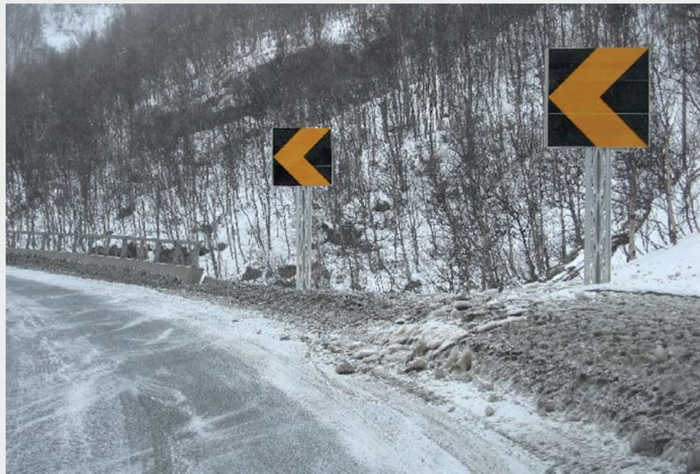
Her er retningsmarkeringer montert på nye gittermaster uten at rekkverksavslutningen er vurdert
