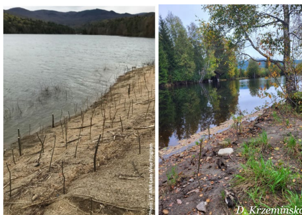
Figur 2. Til venstre, Stiklinger plantet over fiberduk i England og til høyre, over rotstokker (se avsnitt 3.2) i Gjødingelva i Norge
