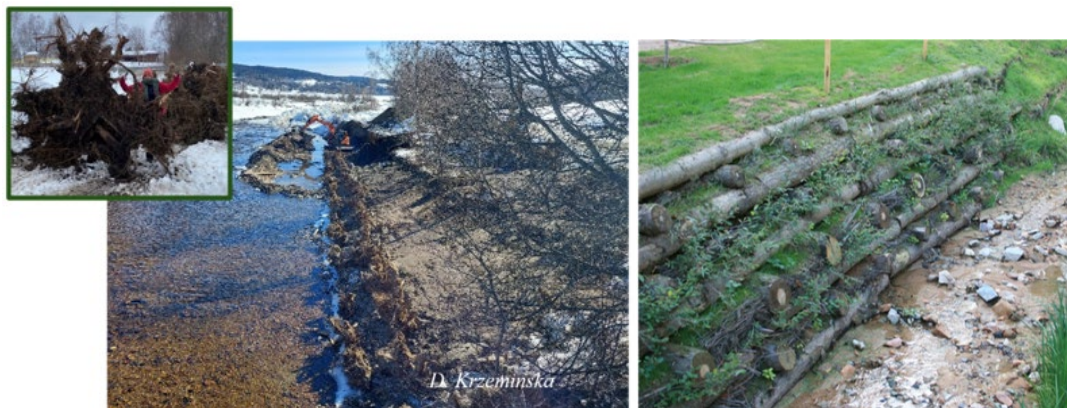
Figur 5. Venstre bilde viser rotstokkmetoden i Gjødingelva (Norge) og høyre bilde er et eksempel av krybbevegg strukturer i Spania, hentet fra Naturalea (se Tabell 3).
