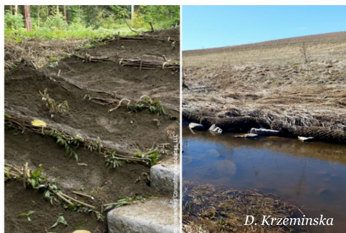
Figur 6. Til venstre, levende faskiner, eksempel fra USA (etter The Vermont Bioengineering Manual, 2022) og til høyre, fiberruller, Svinna (Norge).
