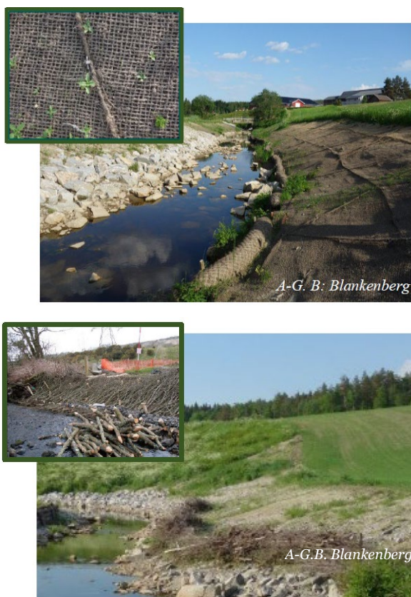
Figur 3. Det øverste bildet viser eksempel på bruk av kokosmatter, Svinna (Norge). Det nederste viser eksempler på «stiklingsmatter», Svinna (Norge) og eksempel fra https://www.salixrw.com/ , innrammet i midten.
