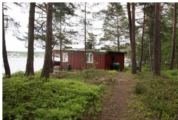
Figur 48. Østhytta sett fra nordvest. Foto: Hallvard Elven.
