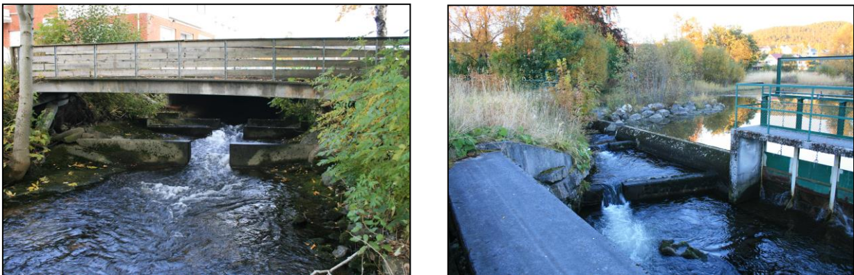
Fig. 10. Spjolkavikelva har to kritiske passasjer for oppvandrende fisk. Til venstre : Betongkonstruksjon nedenfor tunell under butikkssenter gir svært dårlig oppvandring ved lave vannføringer og bør bygges om snarest. Til høyre : Fisketrapp i utløpet av Lillevatn gir god oppvandring av gytefisk.
