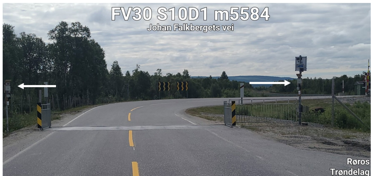
Bilde 3. Plassering av to bevegelsesaktiverte lydavspillende enheter (markert med piler) ved lokaliteten Harborg (øst og vest) rørferist ved Fylkesvei 30. Foto: Morten Aune.
