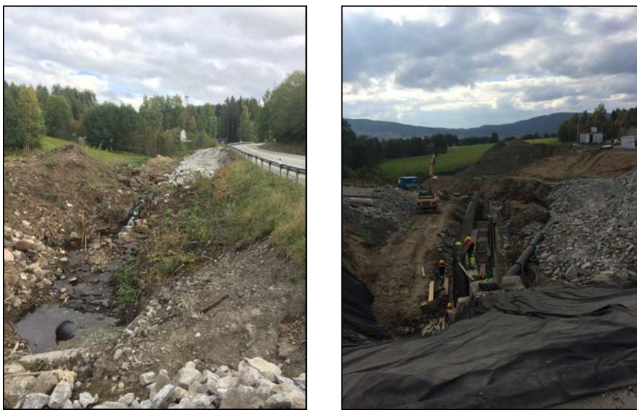
Fig. 2. Anleggsområdet i september 2014 i Slevikbekken. Venstre: Oppstrøms. Høyre: nedstrøms veikryss.
