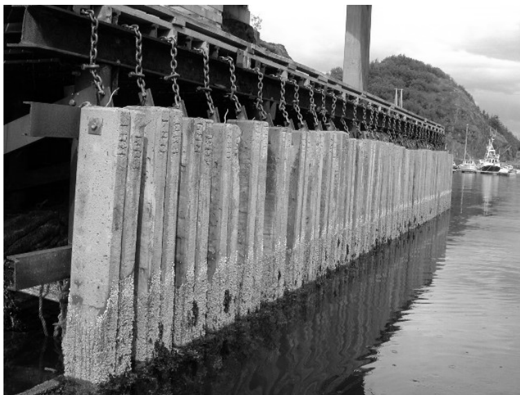
Figur 70 Bjelkeelementer opphengt delvis neddykket i sjøvann i Sandnessjøen. Fra Rannem Isaksen & Holtmoen (1994).
