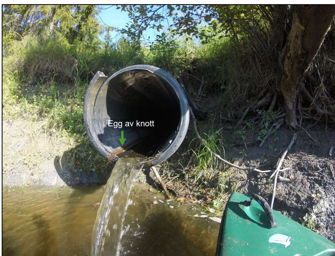
Fig. 8. Drensrør 11.7.2019 som munner ut i bredden fra øst i roligflytende parti i Ågårdselva, med egg av knott lagt som en sammenhengende brun stripe innover i røret. Eggene er artsbestemt ved DNA- strekkoding til S. ornatum .
