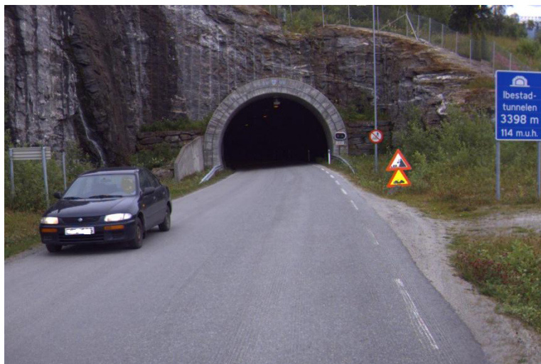
FIGUR 85 DEN UNDERSJØISKE IBESTADTUNNELEN PÅ FV 848 (FOTO: STATENS VEGVESEN)
