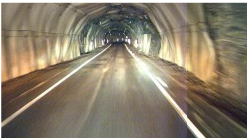
FIGUR 5 EKSEMPEL PÅ UBESKYTTETE PLATER AV POLYETYLEN(PE) SKUM (FOTO: STATENS VEGVESEN)
