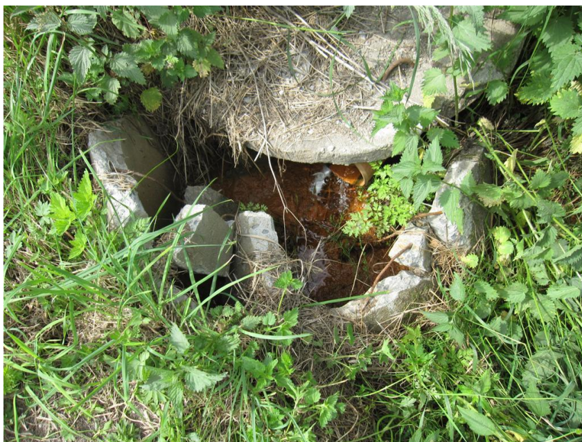
FIGUR 6 EKSEMPEL PÅ KNUST BETONGKUM (FOTO: STATENS VEGVESEN)
