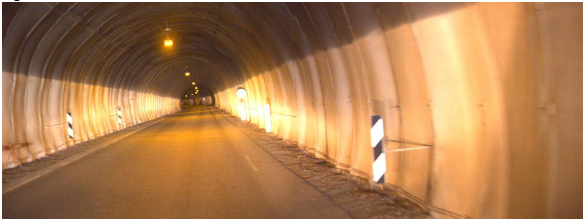
FIGUR 87 PLATER AV PE-SKUM I STORFJELLTUNNELEN PÅ FV 883 I ALTA KOMMUNE (FOTO: STATENS VEGVESEN)
