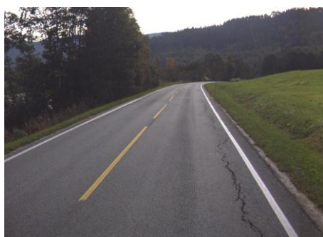
FIGUR 61 KORT DEKKELEVETID PÅ FV 680 I HEMNE KOMMUNE GRUNNET FOR SVAKT VEGFUNDAMENT, OBSERVERT DEKKELEVETID ER KUN 7 ÅR NÅR TRAFIKKEN TILSIER DEKKELEVETID PÅ MINST 12-16 ÅR (FOTO: STATENS VEGVESEN)
