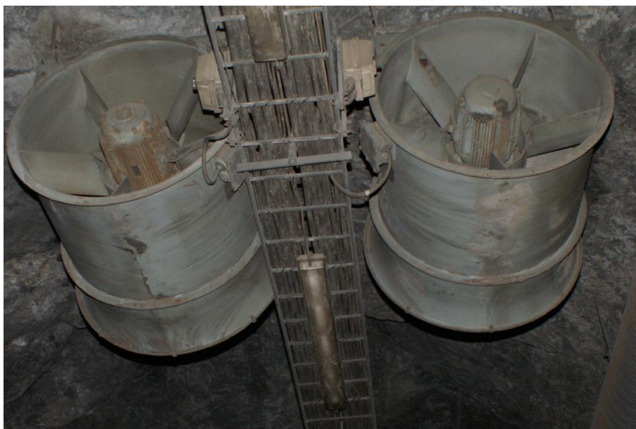
FIGUR 37 SLITTE VIFTER I PORSGRUNNTUNNELEN PÅ FV 356 (FOTO: DAG ØDEGÅRD, STATENS VEGVESEN)
