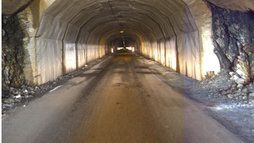
FIGUR 70 STEINFJELLTUNNELEN PÅ FV 773 I NAMSSKOGAN KOMMUNE (FOTO: STATENS VEGVESEN)
