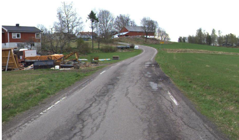
FIGUR 33 LAVTRAFIKKERTE VEGER MÅ OGSÅ VEDLIKEHOLDES FOR AT DEKKET IKKE SKAL GÅ I OPPLØSNING – HER FRA FV 780 I RE KOMMUNE (FOTO: STATENS VEGVESEN)
