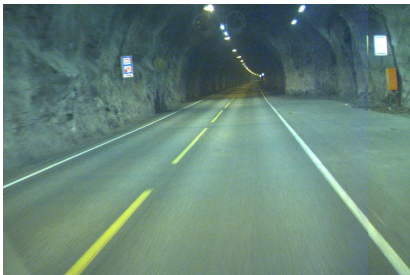
FIGUR 49 DET ER REGISTRERT STORE BEHOV KNYTTET TIL OPPFYLLELSE AV TUNNELSIKKERHETS-FORSKRIFTEN OG ELEKTROFORSKRIFTER I FOLGEFONNTUNNELEN PÅ FV 551 (FOTO: STATENS VEGVESEN)
