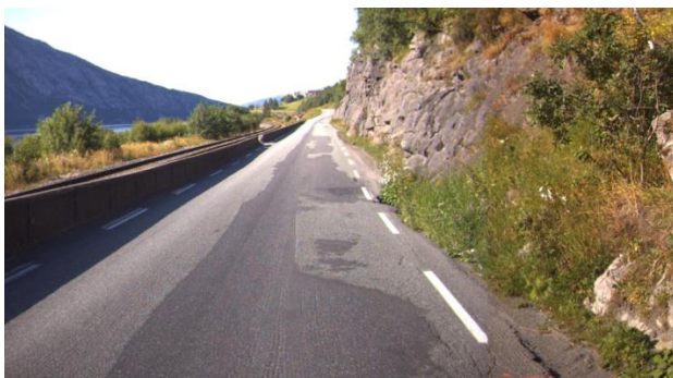
FIGUR 72 SMAL VEG MED MANGELFULL DRENERING OG SKADET VEGDEKKE PÅ FV 78 NÆR MOSJØEN: FØR OPPSTART AV UTBEDRING (TIL VENSTRE) OG ETTER OPPSTART AV UTBEDRINGSARBEID (TIL HØYRE) (FOTO: STATENS VEGVESEN)
