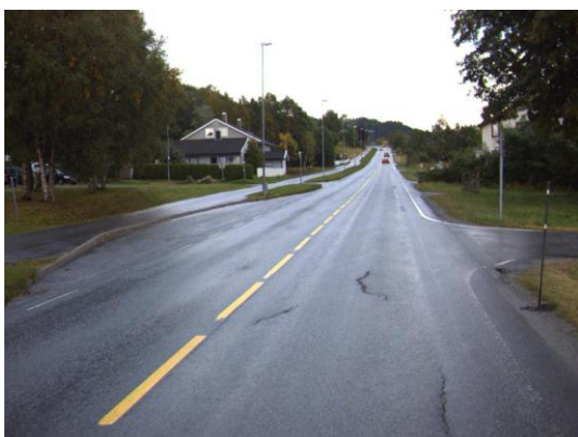
FIGUR 59 DYPE SPOR PÅ FV 45 I VOLDA – OBSERVERT DEKKELEVETID ER KUN 5 ÅR NÅR TRAFIKKEN TILSIER DEKKELEVETID PÅ MINST 10-15 ÅR (FOTO: STATENS VEGVESEN)
