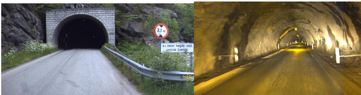
FIGUR 58 HEGGURTUNNELEN PÅ FV 92 I NORDDAL KOMMUNE (FOTO: STATENS VEGVESEN)
