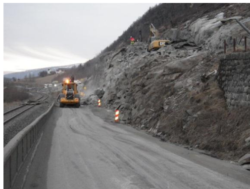
FIGUR 72 SMAL VEG MED MANGELFULL DRENERING OG SKADET VEGDEKKE PÅ FV 78 NÆR MOSJØEN: FØR OPPSTART AV UTBEDRING (TIL VENSTRE) OG ETTER OPPSTART AV UTBEDRINGSARBEID (TIL HØYRE) (FOTO: STATENS VEGVESEN)
