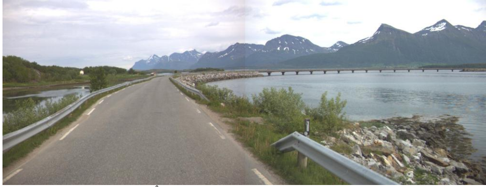
FIGUR 76 ENGELØYBRUA (LAVBRU) PÅ FV 835 I STEIGEN KOMMUNE (FOTO: STATENS VEGVESEN)
