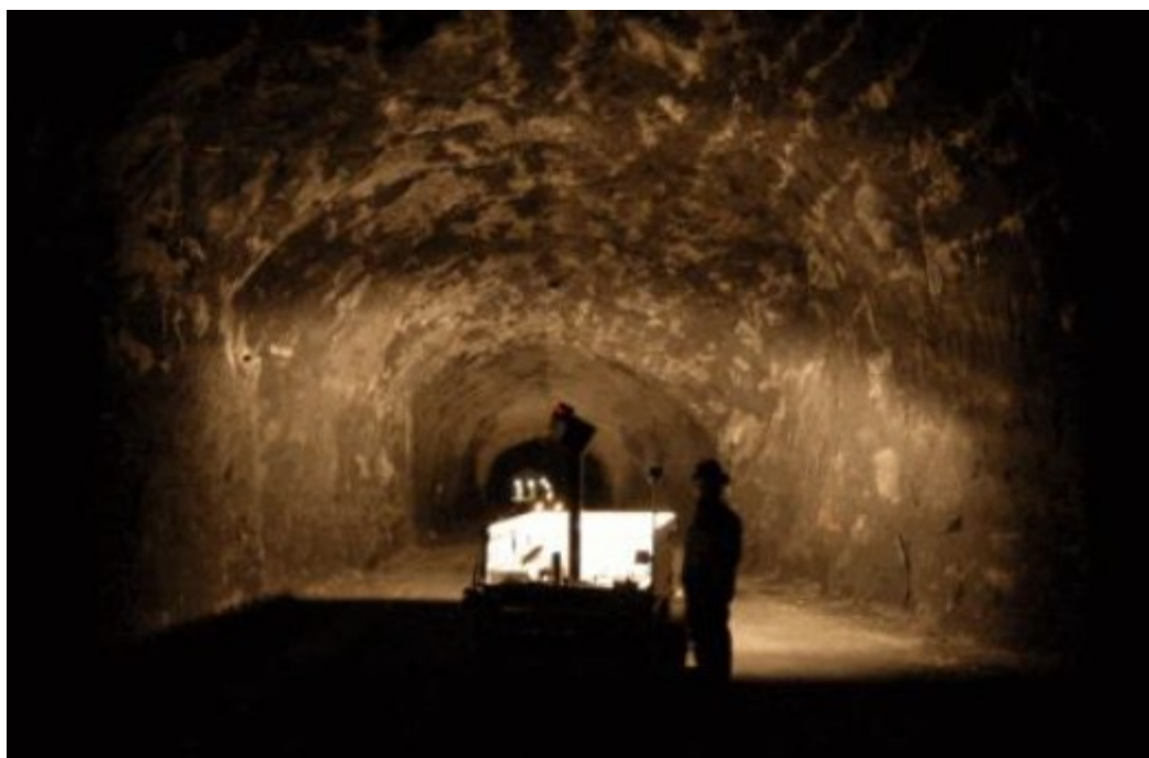
Figur 1 Forsøksfeltet i Runehamartunnelen. (Foto: Bever Control AS)
