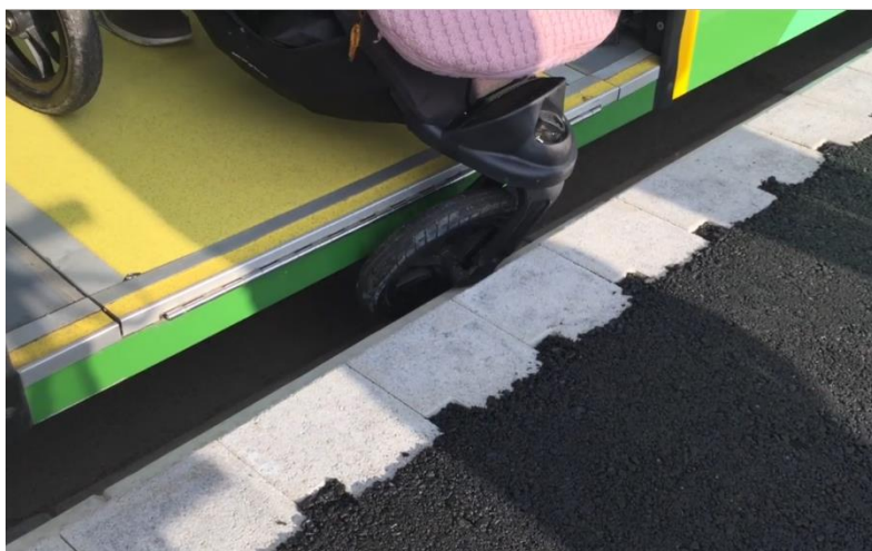
Figur 12 Hjul på barnevogn setter seg fast mellom buss og holdeplass. Foto: Statens vegvesen
