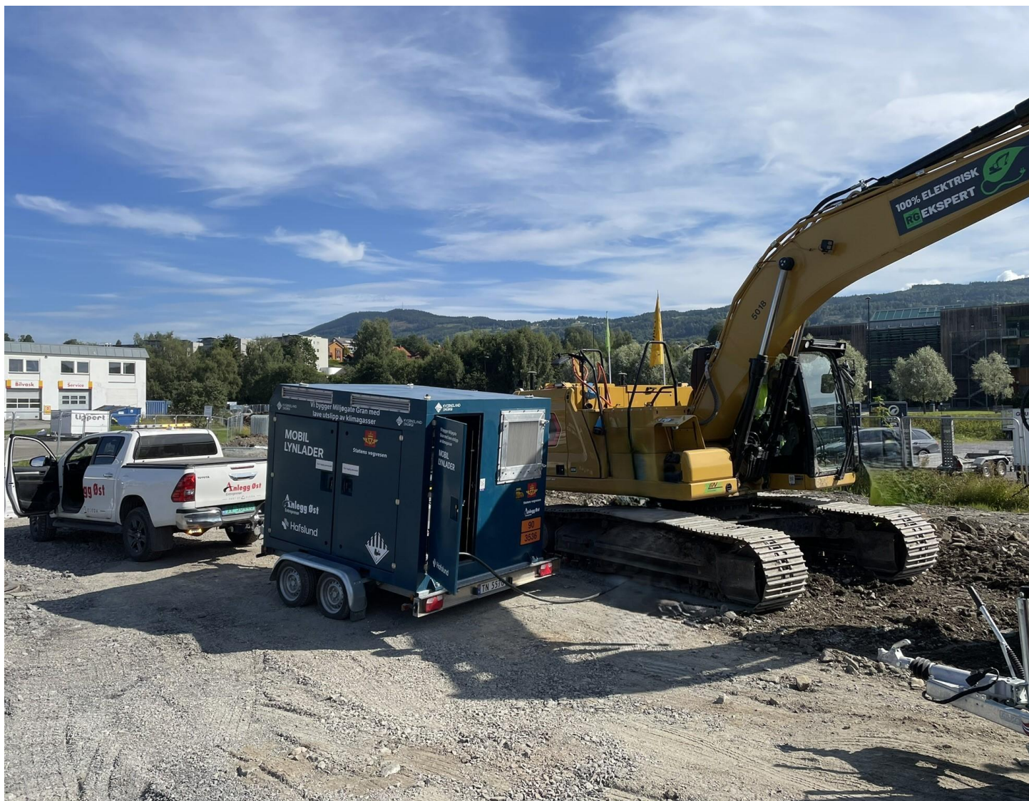
Foto: Håvard Vaaje, Statens vegvesen
