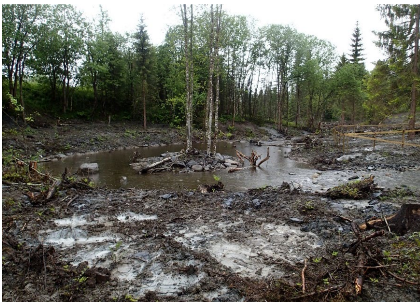
Bilde 2. Parti fra Hofstadelva etter endt rassikring. Foto: Gaute Kjærstad.
