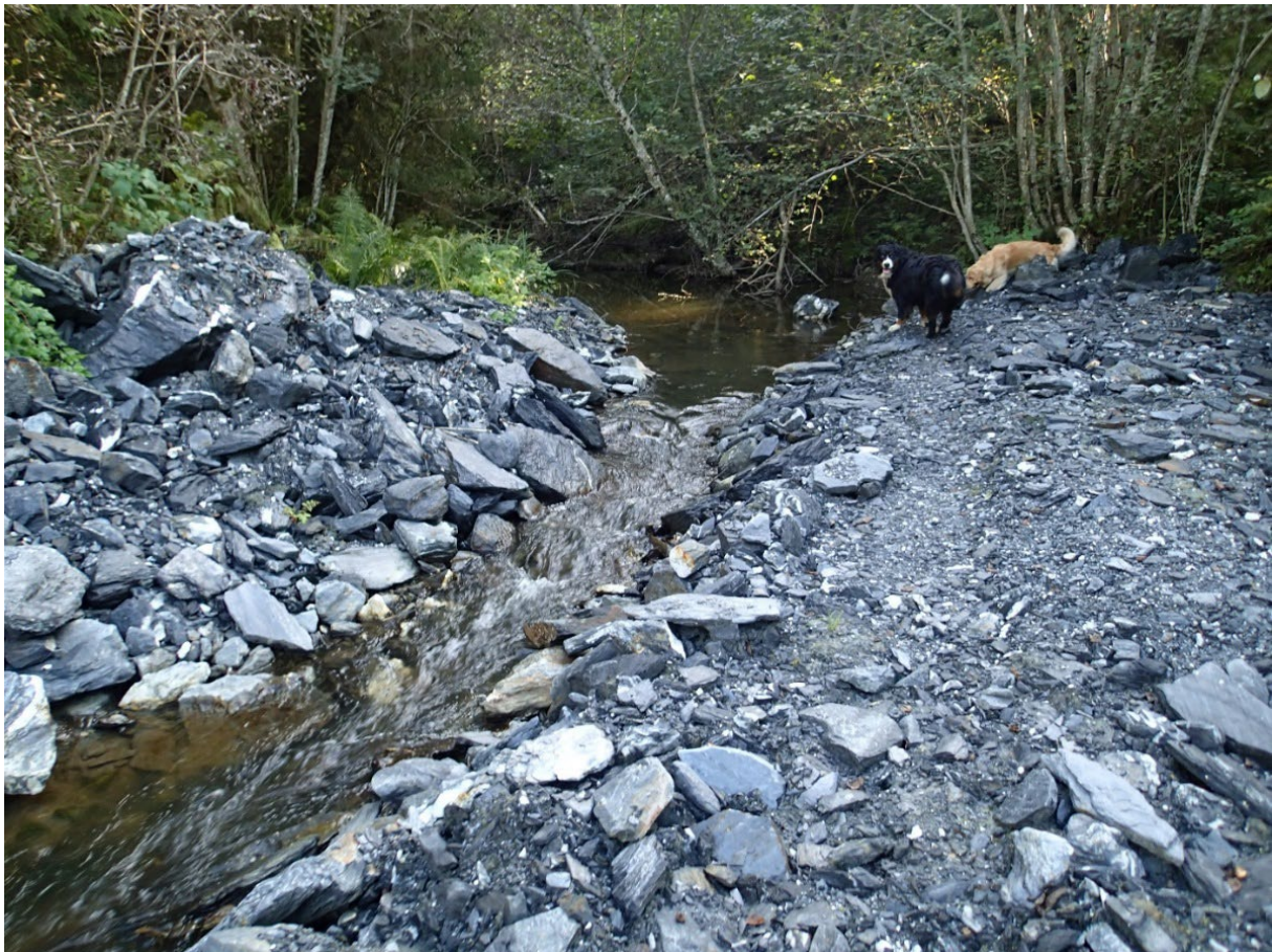
Bilde 1. Hofstadelva. I nederste del av elva har rassikringstiltak for å hindre kvikkleireskred blitt påbegynt, mens elva i øvre del av bildet enda ikke har blitt gravd opp. Foto: Gaute Kjærstad.
