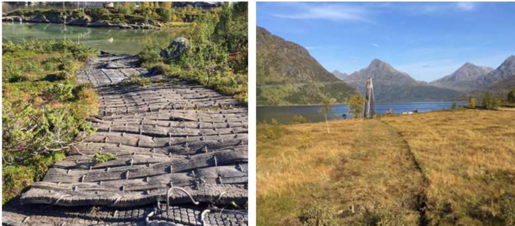
Figur 5. Eksempel på terrengforsterkande tiltak i anleggstida. Venstre bilde viser bruk av matter. Høgre bildet viser et område etter at matter er fjerna. (Kjelde: NVE).
