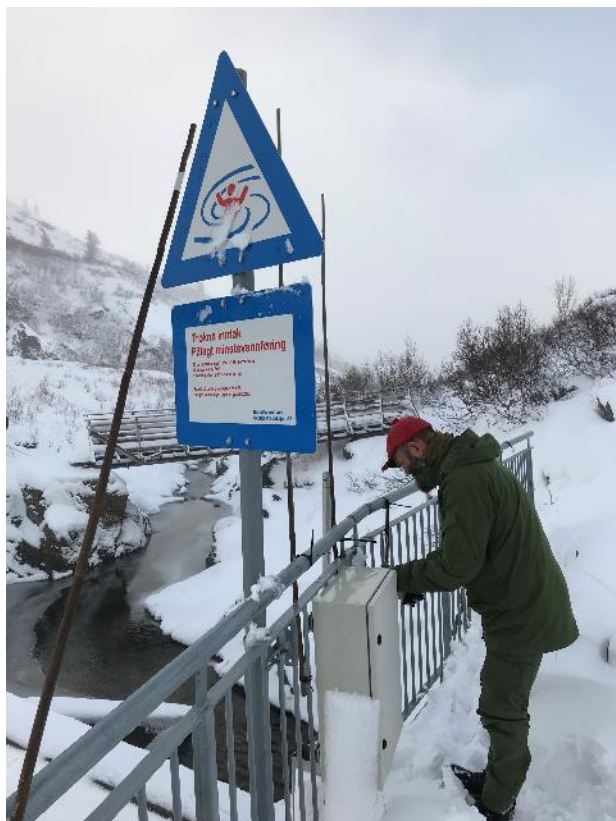
Figur 22. Bildet illustrerer tilsyn av et arrangement for minstevannføring vinterstid. Type arrangement og driftserfaringer vil danne grunnlag for hvor ofte det må gjennomføres tilsyn og innholdet i tilsynet. Foto: NVE
