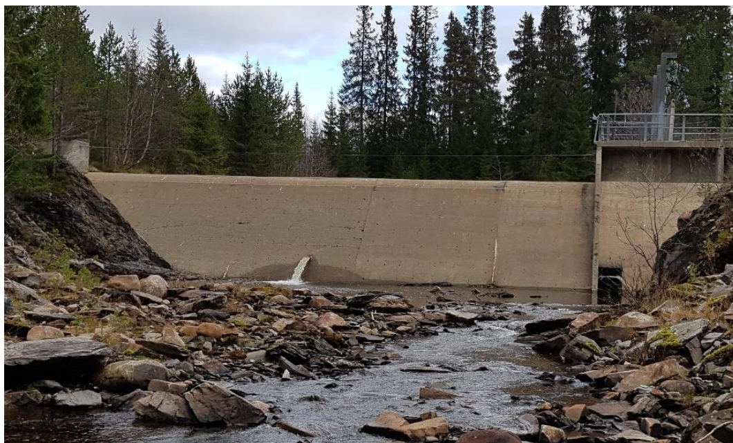
Figur 6. Bildet viser slipp av minstevannføring via et tapperør gjennom damkonstruksjonen. Pålagt minstevannføring var 50 l/s da bildet ble tatt. Minstevannføringen registreres i et V-profil litt lengre nede i elva. Foto: NVE
