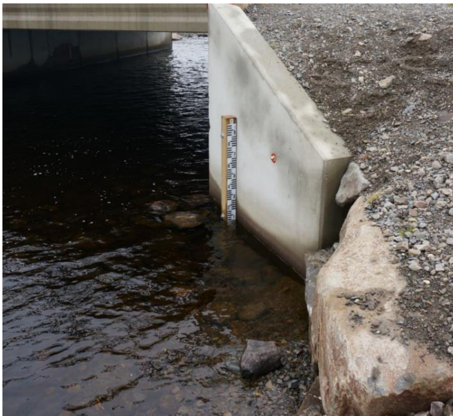
Figur 20. Bildet viser en målestav for avlesning av vannstand og tilhørende minstevannføring i et naturlig elveprofil. Fastmerkebolt er markert med rød maling for god synlighet. Foto: NVE
