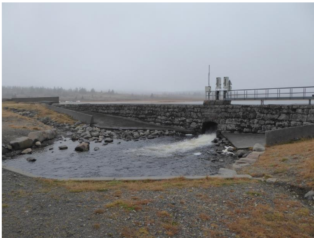
Figur 1. Denne dammen fra 1922 ble bygget om etter at det i 2017 ble satt krav om slipp av minstevannføring i fornyet konsesjon. Minstevannføringen slippes via en glideluke. Det er etablert målepunkt for måling av minstevannføringen ca. 50 meter nedstrøms dammen. Foto: NVE
