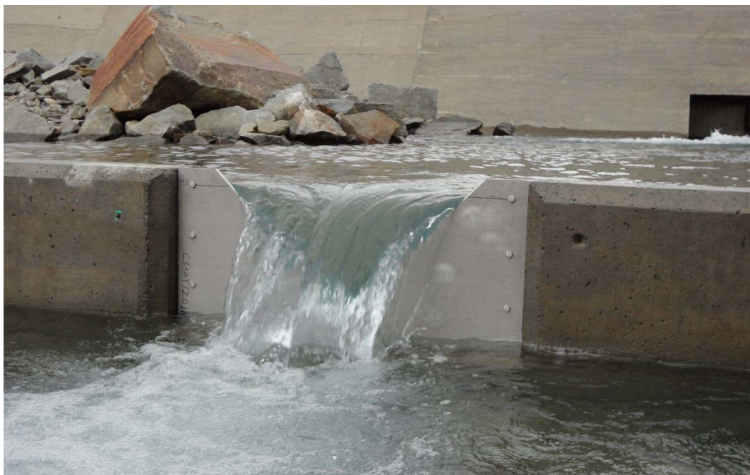
Figur 17. Bildet viser tynnplate V-profil for måling av minstevannføring. Pålagt minstevannføring er her 100 l/s. Inntegnet strek i profilet viser nødvendig vannstand for å oppfylle pålagt vannføring. Foto: Nordkraft
