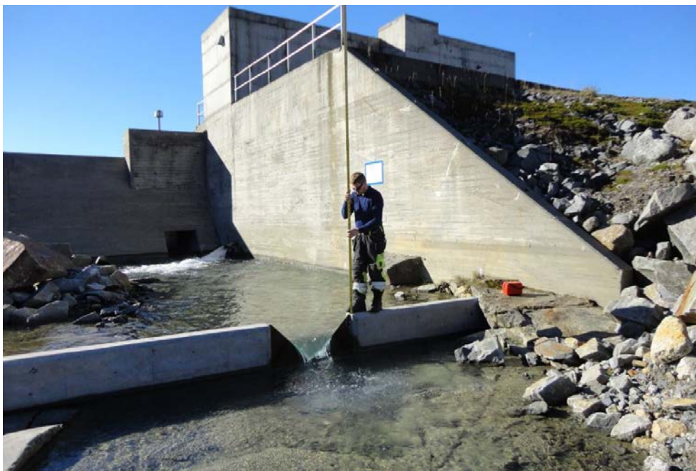
Figur 21. Bildet viser arbeid med nivellering av referansepunkt for trykksensorer ved ombygging av et V-profil. Slikt arbeid krever bruk av riktig kompetanse. Foto: Nordkraft
