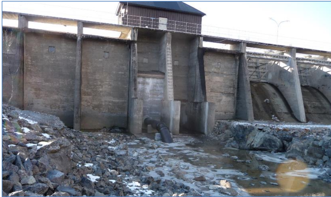
Figur 2. Bildet viser nytt slipparrangement ved Kaldfjorddammen etter ombygging av tappeluke til minstevannføringsrør. Røret er nedstøpt av hensyn til folk som vil krysse elveløpet nedstrøms dammen. Foto: GLB
