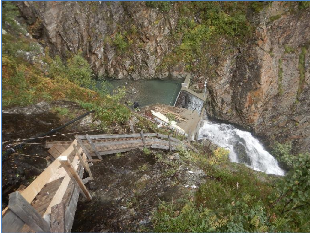
Figur 4. Ved dette anlegget ligger inntaket i en fjellkløft, og adkomsten er utfordrende. Kravet til minstevannføring er 75 l/s om sommeren og 5 l/s om vinteren. Vannføringen reguleres med en fjernstyrt blende. Foto: Småkraft
