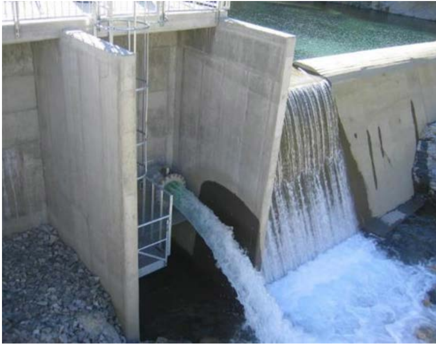
Figur 3. Minstevannføringskravet for dette kraftverket er 760 l/s om sommeren og 100 l/s om vinteren. Vannføringen justeres med en blende. Foto: NVE
