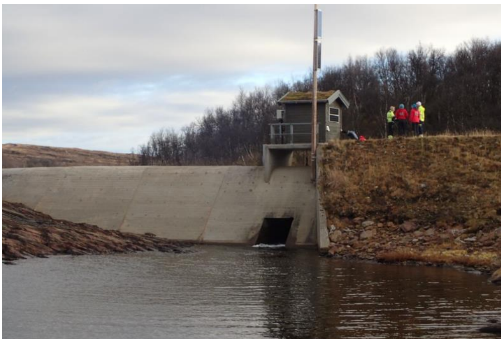
Figur 7. Fra denne dammen slippes minstevannføringen, på 100 l/s sommer og 50 l/s resten av året, fra en luke. Vannføringen registreres i et V-profil nedstrøms dammen. Foto: NVE
