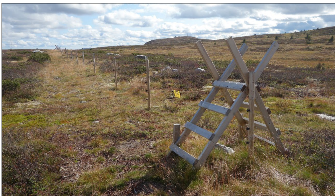
Elektrisk sperregjerde med tre høgder med ståltråd og fleire klyv, her på Breilie (foto: MIA)
