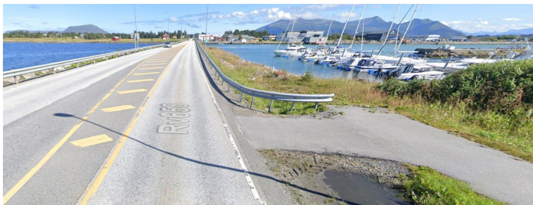
Figur 9.11 Manglende tilrettelegging for gående og syklister over Gjøsundet
