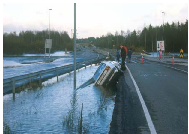
Figur 26. Oppdrift av EPS blokker. Noen fikk glede av EPS blokkene som fløt opp på RV 159 Flom buer. Foto Statens vegvesen.
