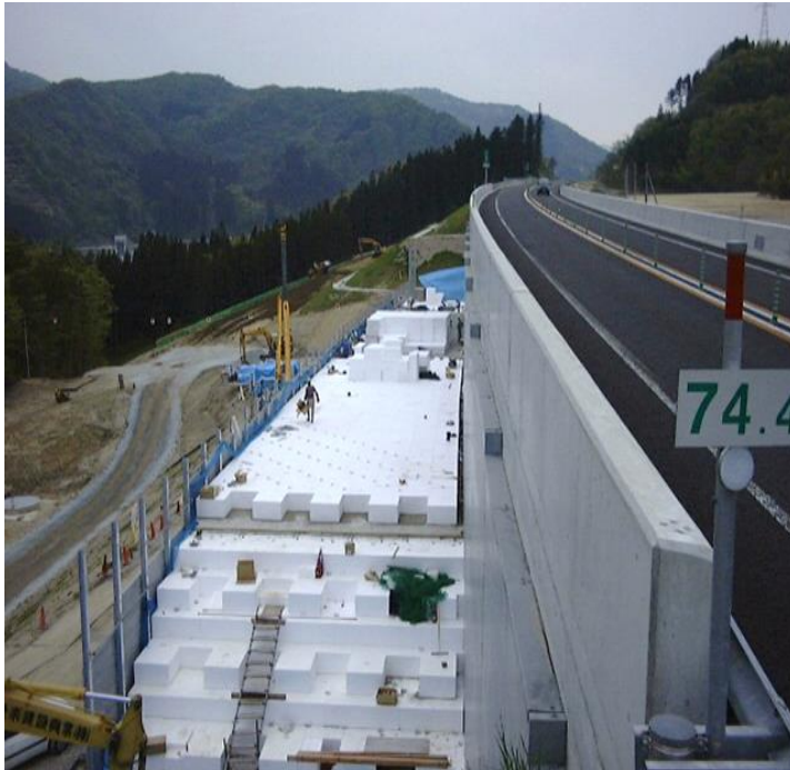
Figur 15. Vertikale fyllinger i Japan. Foto Kristian Aunaas Statens vegvesen.
