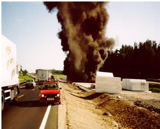
Figur 28. Brufundament skadet av EPS-blokker satt i brann. Foto Statens vegvesen
