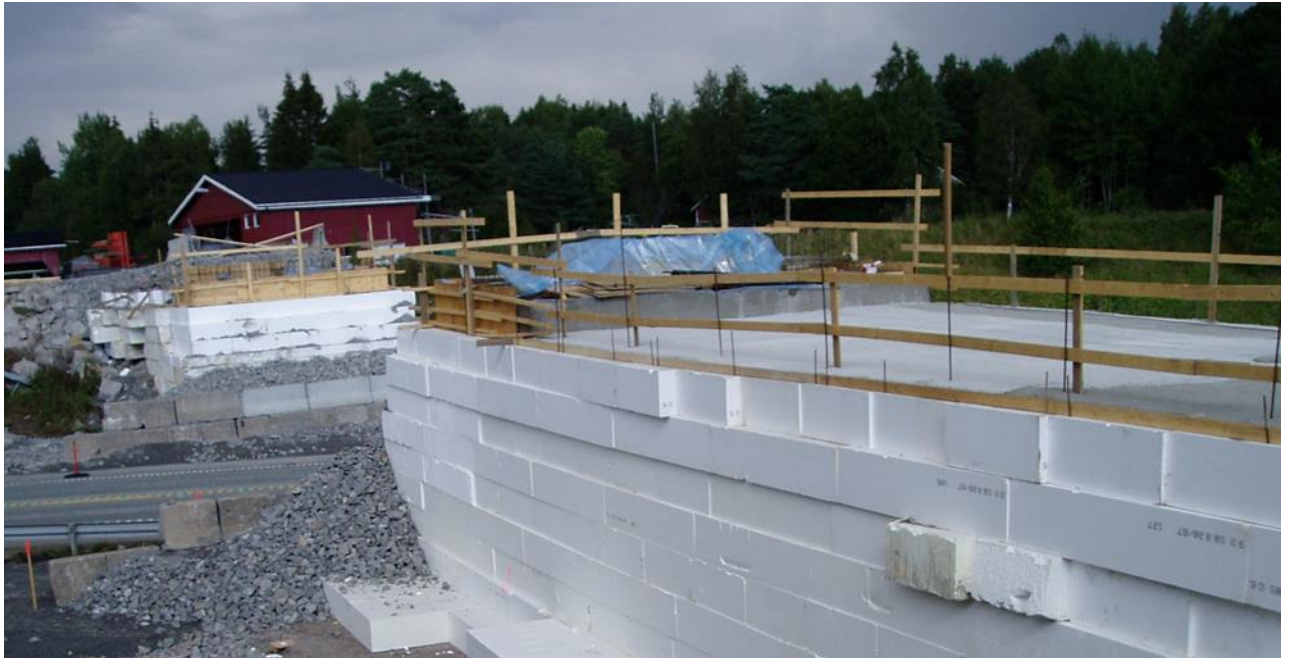
Figur 2. Grimsøyvegen bru, Kryssing av E6. Fundamentering av bru på EPS. Foto Roald Aabøe Statens vegvesen
