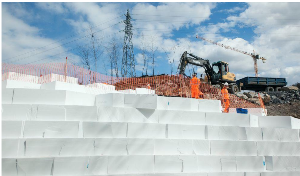
Figur 38. Rundt 28.000 EPS-blokker under den nye påkjøringsrampen ved Løxa i Bærum. Bilde: Mari Gisvold Garathun Teknisk ukeblad 2016
