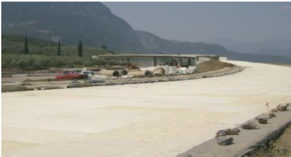
Figur 30. 65.000 m 3 EPS-blokker på E 75 ved Thermopylene, Hellas (Bilde: Sotiropoulos & Associates SA)
