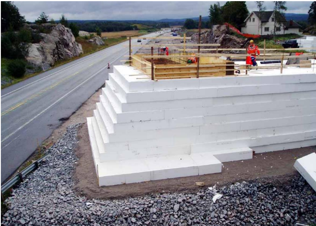
Figur 32 Fyllinger for interimsbru over E 6 ved Gimsøyvegen (Foto; Tor Helge Johansen Statens vegvesen)
