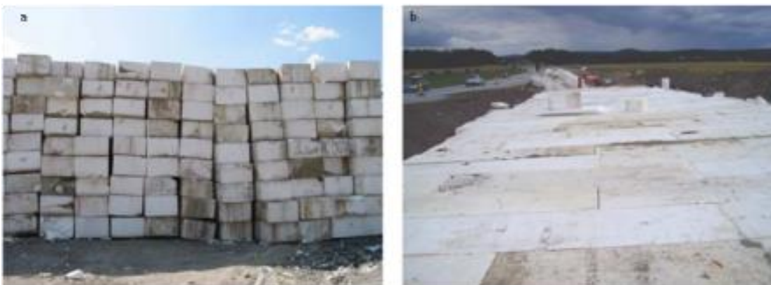
Figur 29. Blokker fra midlertidig EPS fylling på E6 Løkkeberg flyttet til ny utbygging av E6. Foto: Statens vegvesen
