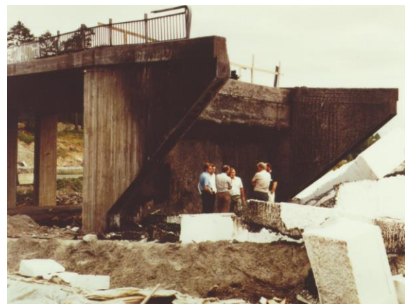
Figur 28. Brufundament skadet av EPS-blokker satt i brann. Foto Statens vegvesen
