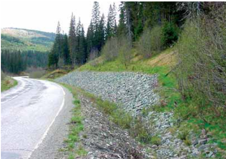
Figur 245.8 Masseutskifting i skråningsfot (Gartland i Nord-Trøndelag. Foto: Kjell Eriksen)
