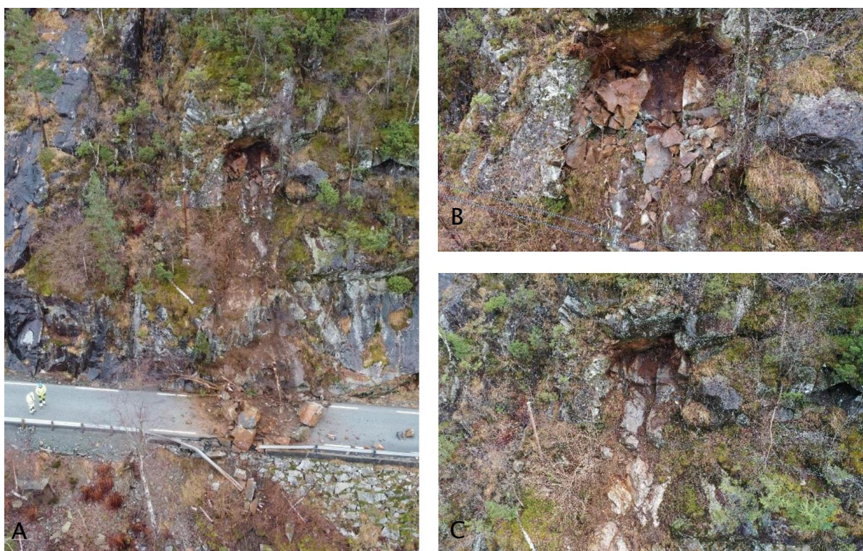
Figur 2. Steinsprang på Rv. 13 ved Breidvika i Suldal, 23. februar 2021 (Solbakken, 2021). Bilde A og B viser skredløp og løsneområde før rensk, og bilde C viser løsneområde etter rensk. Dronebilder tatt av kontrollingeniør gjorde at rensk ble satt raskt i gang, og at vegen kunne åpnes igjen uten at geolog måtte rykke ut. Foto: Peer Einar Klungtveit.
