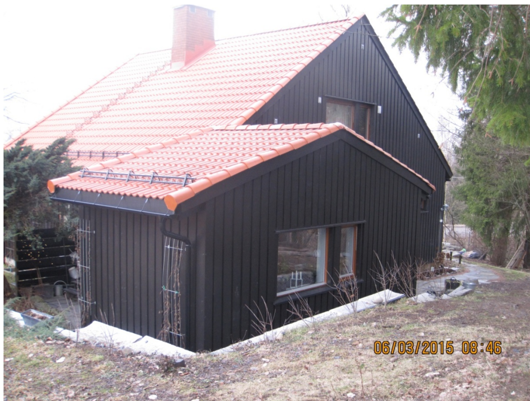
Eksempel på generasjonsbolig i Oslo. En hybel i det opprinnelige bolighuset har blitt utvidet med et tilbygg i form av en ny stue. Foto: Annette Hannestad
