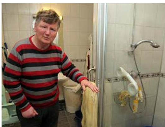
Eksempel på tilpasning av bad. Dusjsonen er utvidet for å få plass til stol. Vanlig dør er erstattet med skyvedør. Illustrasjon fra Husbanken (2014) 6 .
