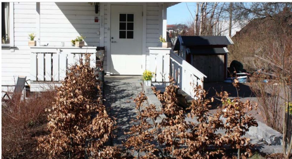
Tilrettelagt inngangsparti. Det ble anlagt en ny hellelagt rampe og inngangspartiet ble utvidet. Den opprinnelige trappen ses til høyre i bildet. Tønsberg kommune. Foto: Tønsberg kommune
