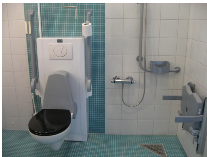
Bruk av kontrastfarger både på gulv/vegg og på toalettet. Illustrasjon fra Almas hus i Oslo.
