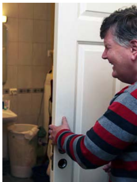
Eksempel på tilpasning av bad. Dusjsonen er utvidet for å få plass til stol. Vanlig dør er erstattet med skyvedør. Illustrasjon fra Husbanken (2014) 6 .
