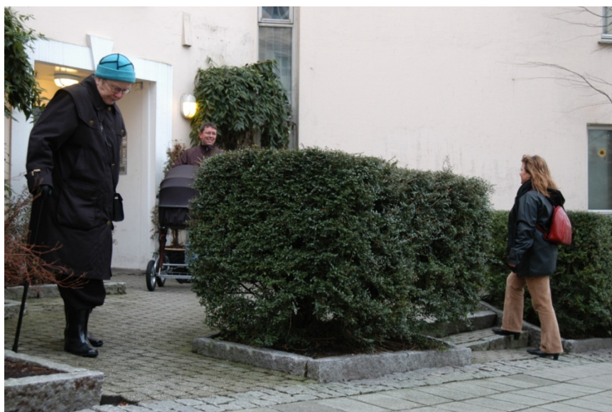
Trinnfri atkomst er en fordel for de som er dårlig til bens og alle som kommer med rullende materiell. Hans Hagues gate i Bergen. Foto: Husbanken v/ Irene Hillestad
