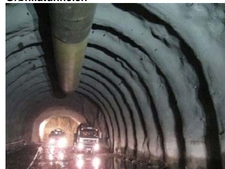
Sikring med sprøytebetongbuer Ringveg vest Bergen
