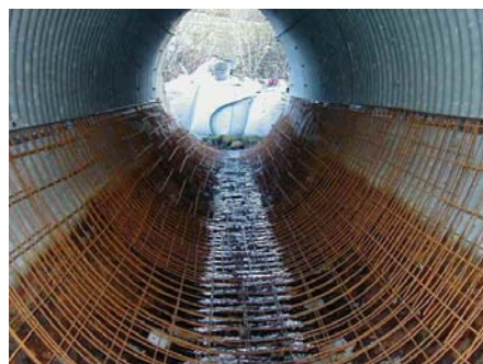
Armeringsnett på plass!
