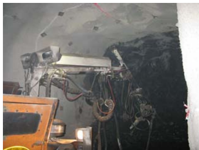
Sikring med sprøytebetong i Ridgeway Deep
