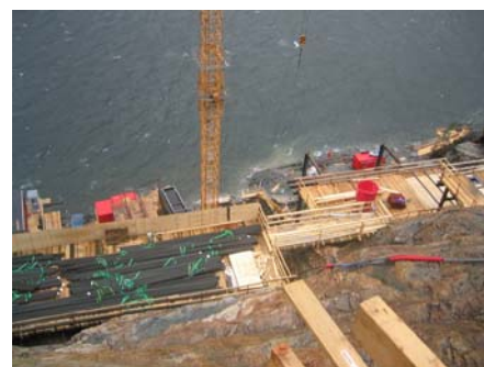
Skrå byggeplass i Hardangerterrenget
