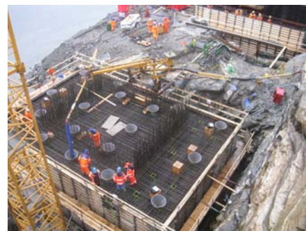
Oppstart støyp av det vestre fundamentet
