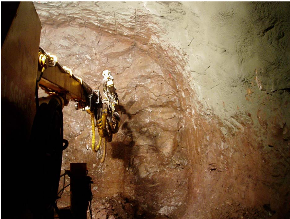
Figur 8 Driving av Frodeåstunnelen (lavabergarten rombeporfyr) i Tønsberg
