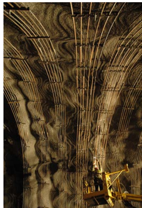
Montering av sprøytebetongbuer i Grønliatunnelen
