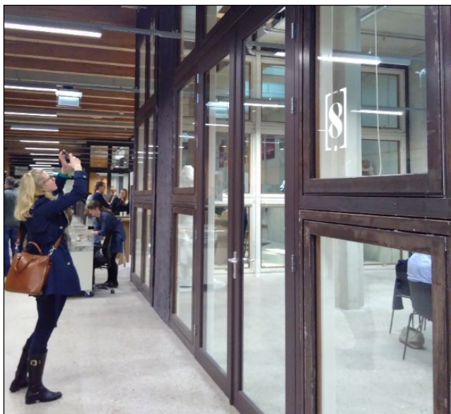
Figur 15 Brukte trevinduer i innervegg. Fra Circl, ABN AMRO Pavilion, i Utrecht, NL. (Foto; ASN)
