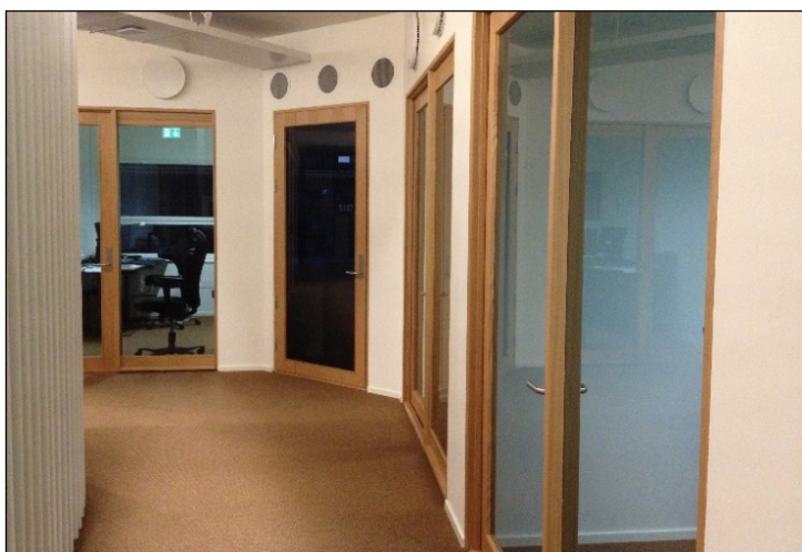
Figur 7 Ombruk av fasadeglass i innvendige skillevegger, Powerhouse Kjørbo. Ved å ombruke glassplater fra eksisterende fasade som kontorfronter, ble klimagassutslippene redusert med over 80% per m 2 skillevegg sammenlignet med nye. Kostnaden for denne løsningen var tilsvarende som om de hadde blitt produsert basert på nye materialer. (Foto; ASN)
