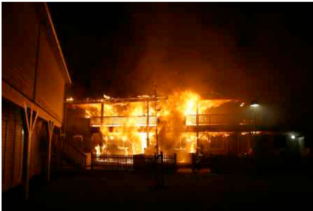
Bilde 13: Golvbord i svalgangen blir antent pga. varme-/ strålingspåkjenning fra flammene som stryker horisontalt oppunder tak og svalgangsgolv. Foto: Recto Correa.
