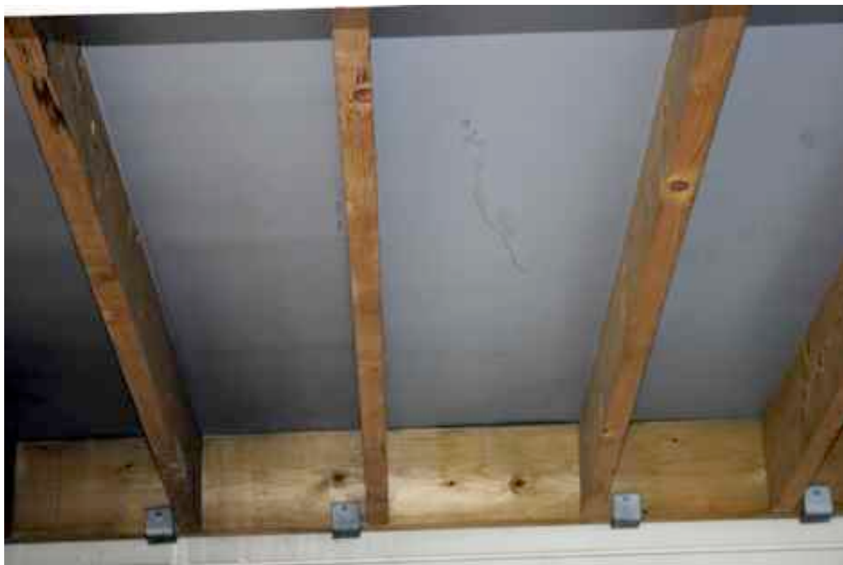
Bilde 8: Underside av balkong
