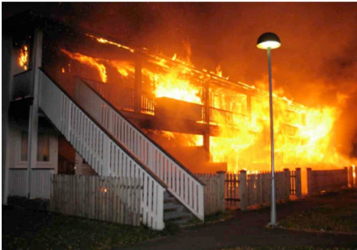
Bilde 6: Brannen på svalgangssida. Foto: Recto Correa.
