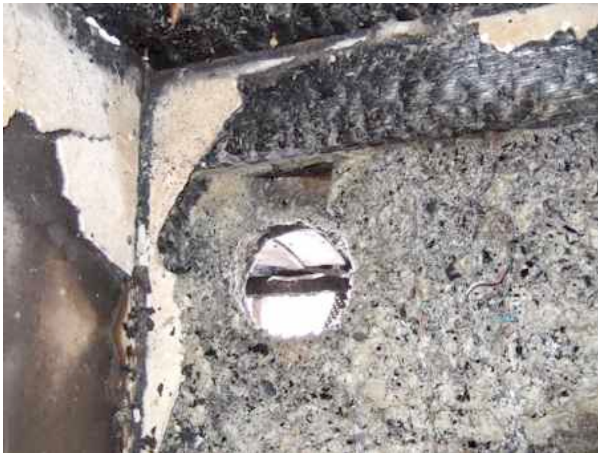
Bilde 12: Her har det vært en ventil i veggen ut mot svalgangen.
