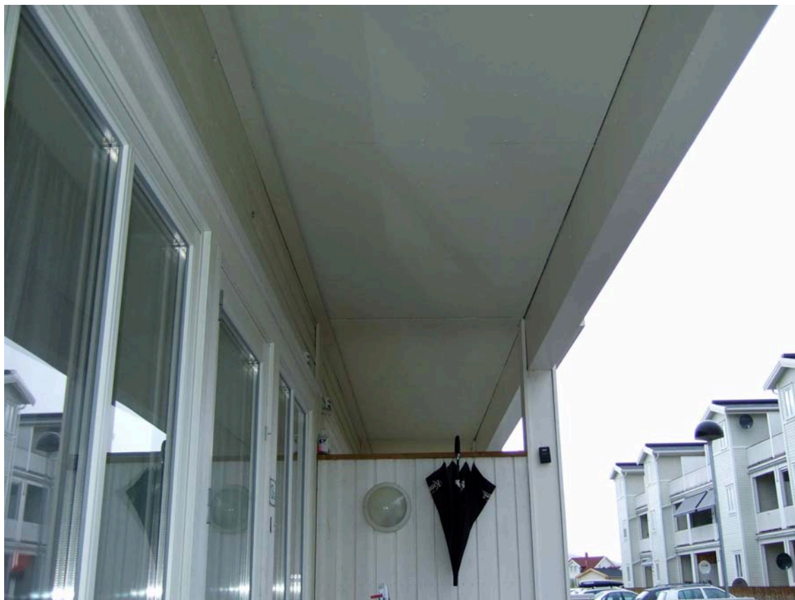
Bilde 9: Underside av dekke/golv for svalgangen.
