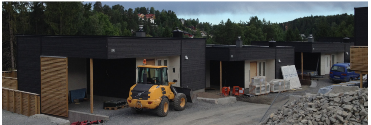
Figur V 25. Bilde under bygging, TEK10-prosjekt TEK 2
