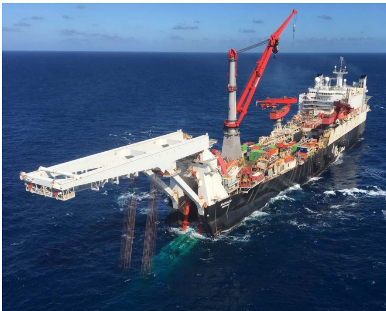
Figur 3.11 – Rørleggingsfartøy utstyrt for S-metoden med en stinger. Foto: Allseas
