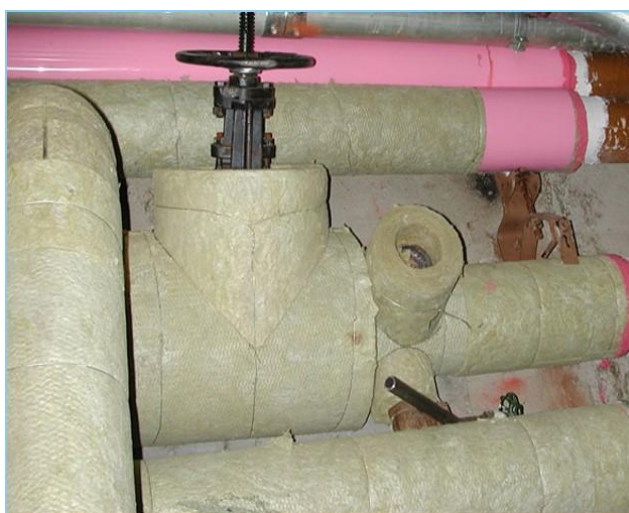
Figur 4 –Steinull brukt på rør og ventiler, før montering av kapsling.
