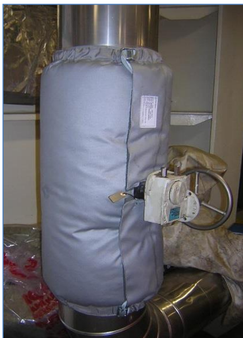
Figur 12 – Isolasjonspute for varmeisolering av ventil.
