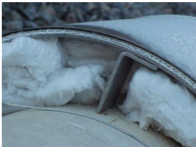
Figur 5 – AES-fiber installert direkte mot røroverflate.
