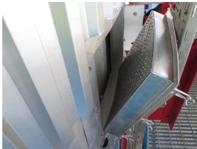
Figur 22 – Eksempel på robust løsning med avstandsisolering og luke for inspeksjon.
