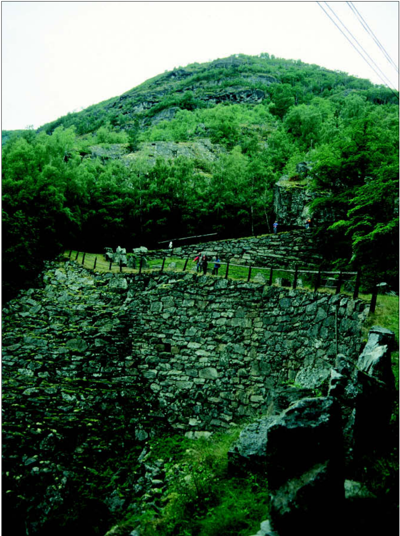
Figur 2.1 Den gamle veiforbindelsen mellom Østlandet og Vestlandet slynger seg gjennom Vindhella i Lærdal. De oppmurte partiene fra 1840-årene har en høyde på opptil 12 meter.
