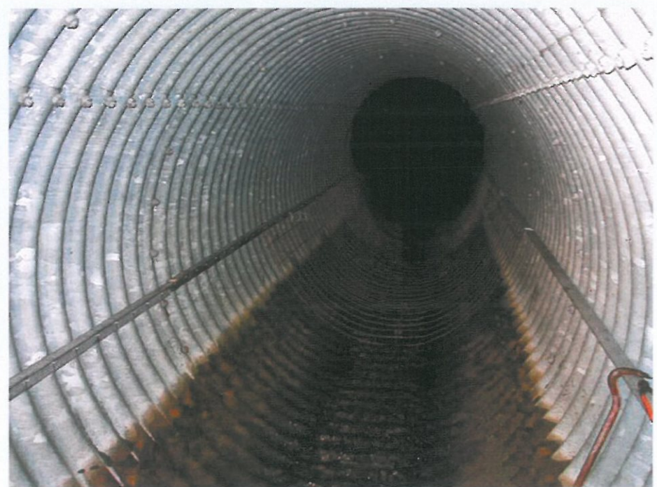
Vinkeljern ferdig montert
