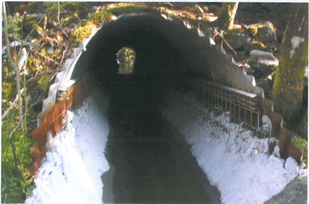
Støping for hånd ferdig
